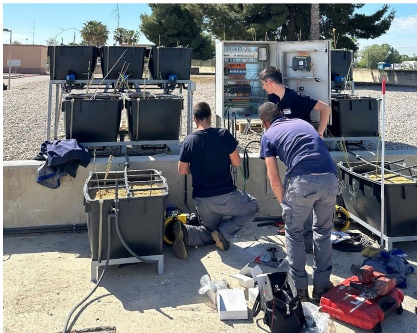
**Figura 22:** Instalación de cuadro eléctrico.
