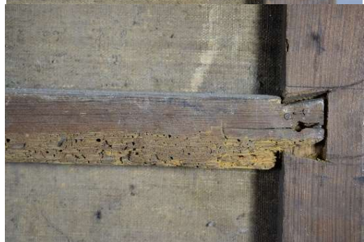
Figura 33. Detalle del ataque de insectos xilófagos.
