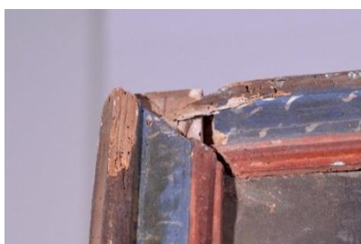
Figura 27. Faltante de madera del marco.
