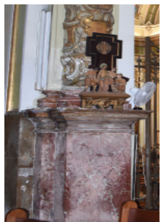
Fig 10. Imatge dels marbres del sòcol.
