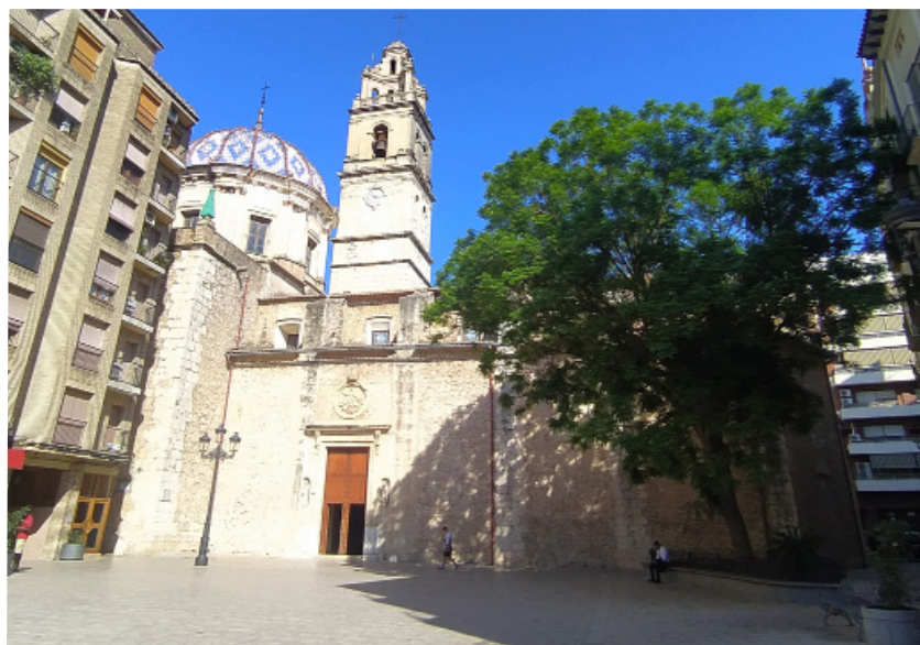
Fig 2: Vista general de la façana nord del temple.
