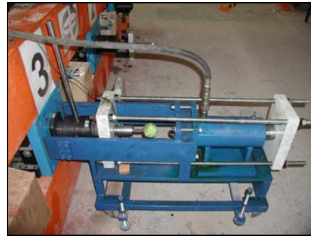
Fig. 3.47. Extremo de transmisión. Tesado finalizado. Sistema hidráulico y sistema mecánico en posición.
