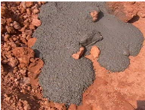
Fig 8.9. Hormigón vertido cohesivo
