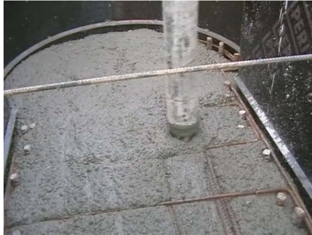
Fig. 8.23. Última capa de hormigonado
