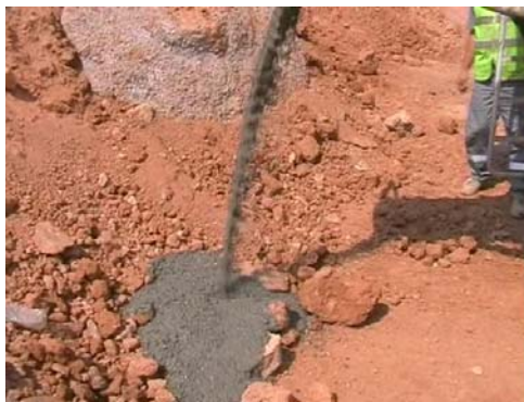
Fig. 8.17. Vertido desde camión para control de recepción
