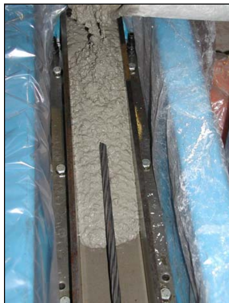
Figura 3.48 Hormigonado de la probeta.
