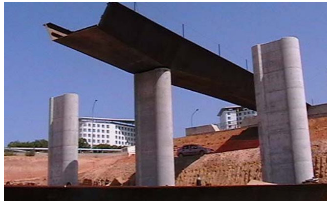
Fig. 8.24. Aspecto final de las pilas - lado Valencia
