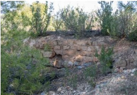
Figura 6.17. Alzado en cuadrado de excavación inundable del Tossal del Moro (Pinyeres, 2023).
