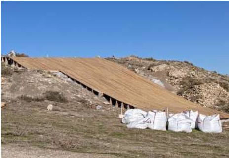
Figura 9.116. Cubierta temporal sobre ladera de los restos del Cerro de la Virgen (Orce, 2022).
