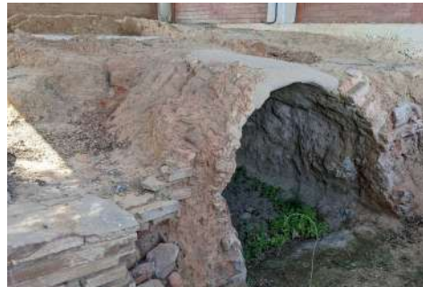
Figura 3.15. Estructura portante de ladrillo en Camp d'en Ventura de l'Oller (St. Perpetua de Moguda, 2022).
