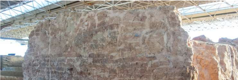
Figura 9.61. Consolidación de grietas, fisuras y oquedades mediante mortero en el yacimiento arqueológico de Cancho Roano (Zalamea de la Serena, 2022).
