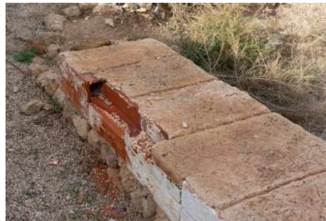
Figura 9.94. Reconstrucción in situ con ladrillo cerámico en Coimbra del Barranco Ancho (Jumilla, 2022).
