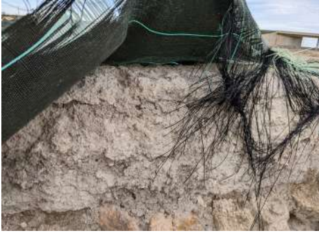
Figura 9.105. Cubrimiento textil de reconstrucciones de adobe en La Caridad (Caminreal, 2022).
