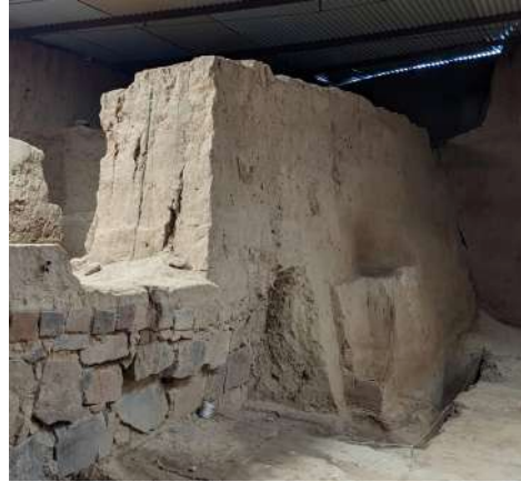
Figura 5.33. Desplome estabilizado con contrafuertes en Casas del Turuñuelo (Guareña, 2022).
