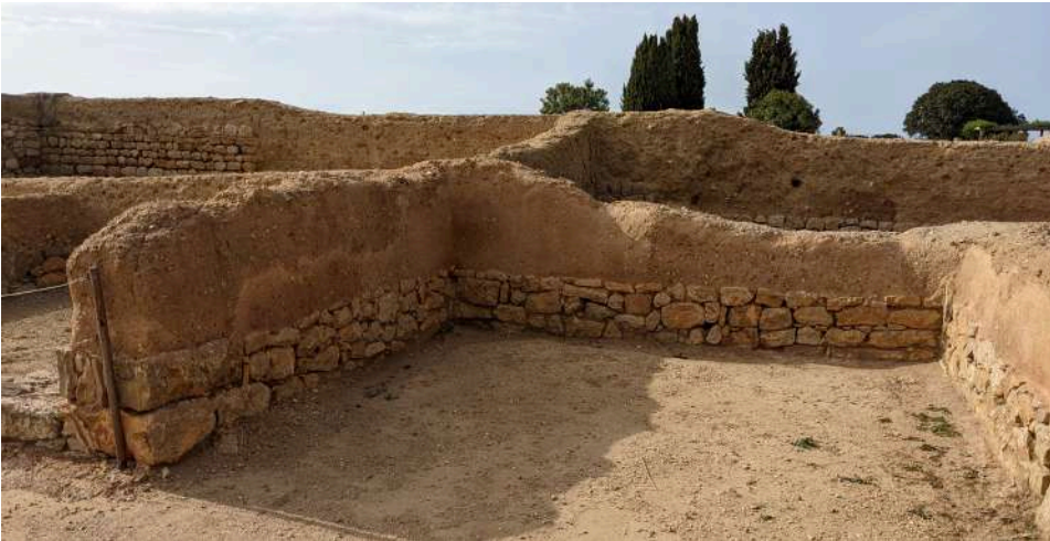
Figura 3.55. Muros de tapia intervenidos en las domus romana 2B del yacimiento arqueológico de Ampúrias (Girona, 2022).
