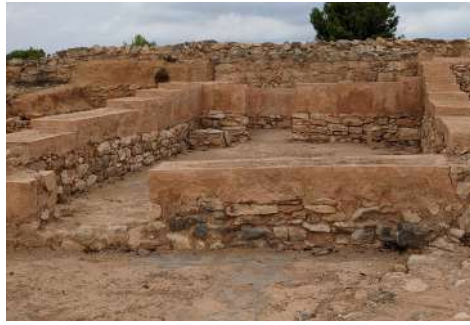
Figura 9.40 y 9.41. Encapsulado y protección de muros de adobe en el yacimiento del Tos Pelat (Moncada), con regularización de aristas, alteración visual y manchas de humedad (derecha, 2022).
