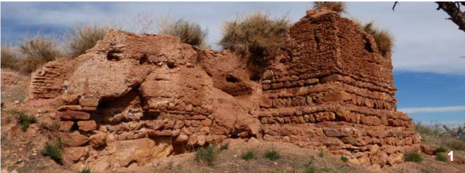
Figura 9.68. Restauración en tapias del yacimiento de Ampurias (San Martín de Ampurias, 2022).
