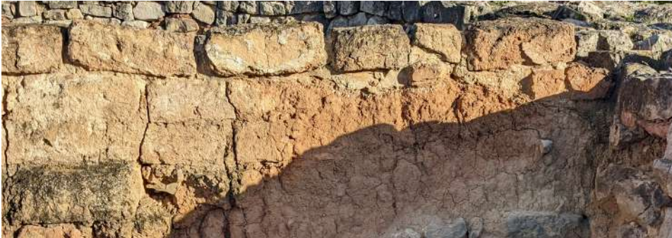
Figura 9.31. Sombrero de muro mediante hilada de adobes caídos hallados en la excavación, de mayor dureza por exposición a altas temperaturas, en el Turó del Calvari (Villalba de los Arcos, 2022).
