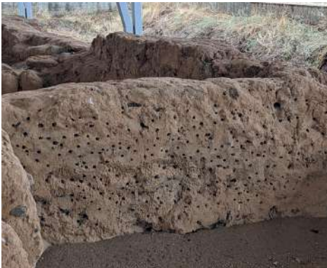
Figura 5.29. Oquedades de abejas terreras y escarabajos en Cancho Roano (Zalamea de la Serena, 2022).
