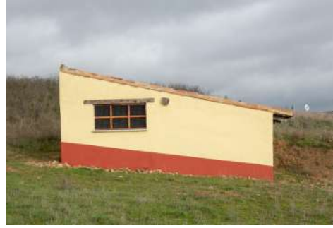
Figura 9.135. Edificio contenedor del horno de adobe La Jericó (Herrera de Pisuerga, 2022).
