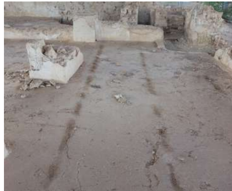
Figura 5.39. Vertido de óxido de vigas de cubierta en la mezquita del cortijo del centeno (Lorca, 2022).
