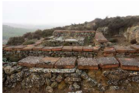
Figura 7.18. Durabilidad y falsa dureza o ausencia de mantenimiento en El Amarejo (Bonete, 2022).
