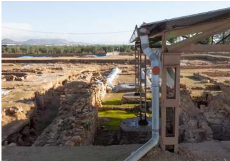
Figura 10.111. Vertido de agua de cubierta al entorno, incrementando la humedad (Yecla, 2022).
