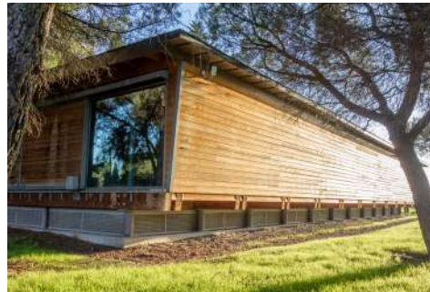
Figura 9.139. Edificio contenedor de los restos de tierra del Cerro de la Mota (Medina de Campo, 2022).
