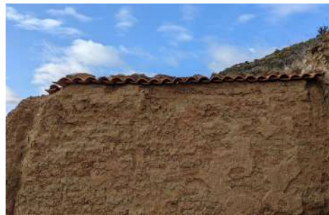
Figura 6.30. Surcos de escorrentía concentrada en extremos de sombrero en Bilibis (Calatayud, 2022).
