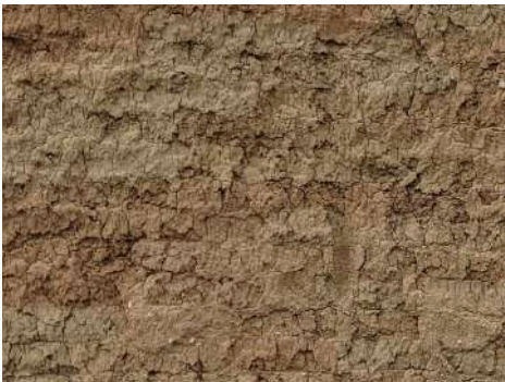
Figura 5.12. Microfisuras en superficie por procesos de evaporación en Bilbilis (Calatayud, 2022)
