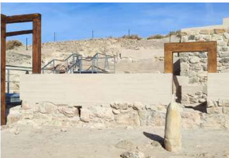
Figura 9.91. Reconstrucción in situ con hormigón en los restos de Puente Tablas (Puente Tablas, 2022).
