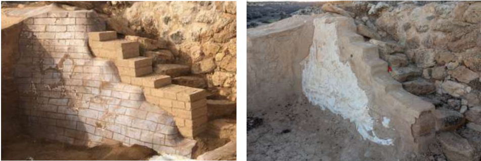
Figura 9.50 y 9.51. Encapsulado con simulación de aparejo en superficie, tras su ejecución (izquierda, 2018), y en la actualidad (derecha, 2023), en el yacimiento de Plaza de Moros (Villatobas).
