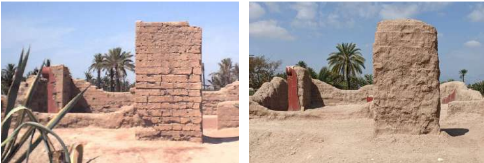
Figura 9.96 y 9.97. Evolución de la reconstrucción descubierta y ex situ del templo ibérico de adobe en el yacimiento de La Alcudia / Ilici (Elche). Estado previo (izquierda, 2001) y actual (derecha, 2022).
