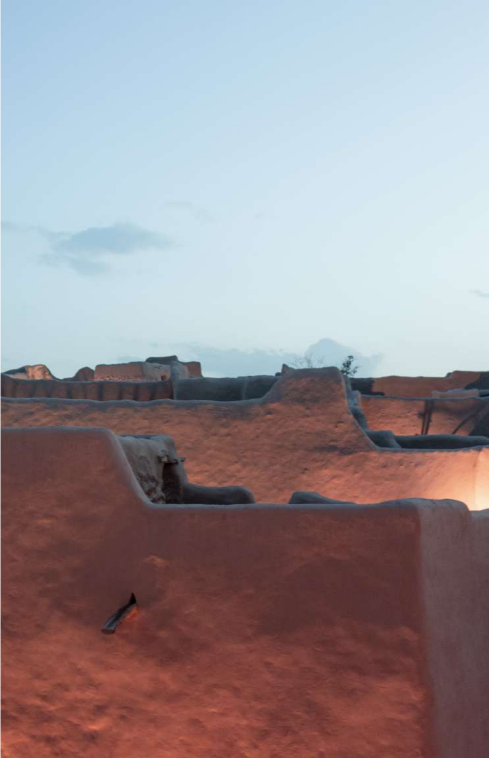
Figura 2.36. Muros de adobe en el yacimiento arqueológico de Al-Turaif, Riad (Arabia Saudí).
