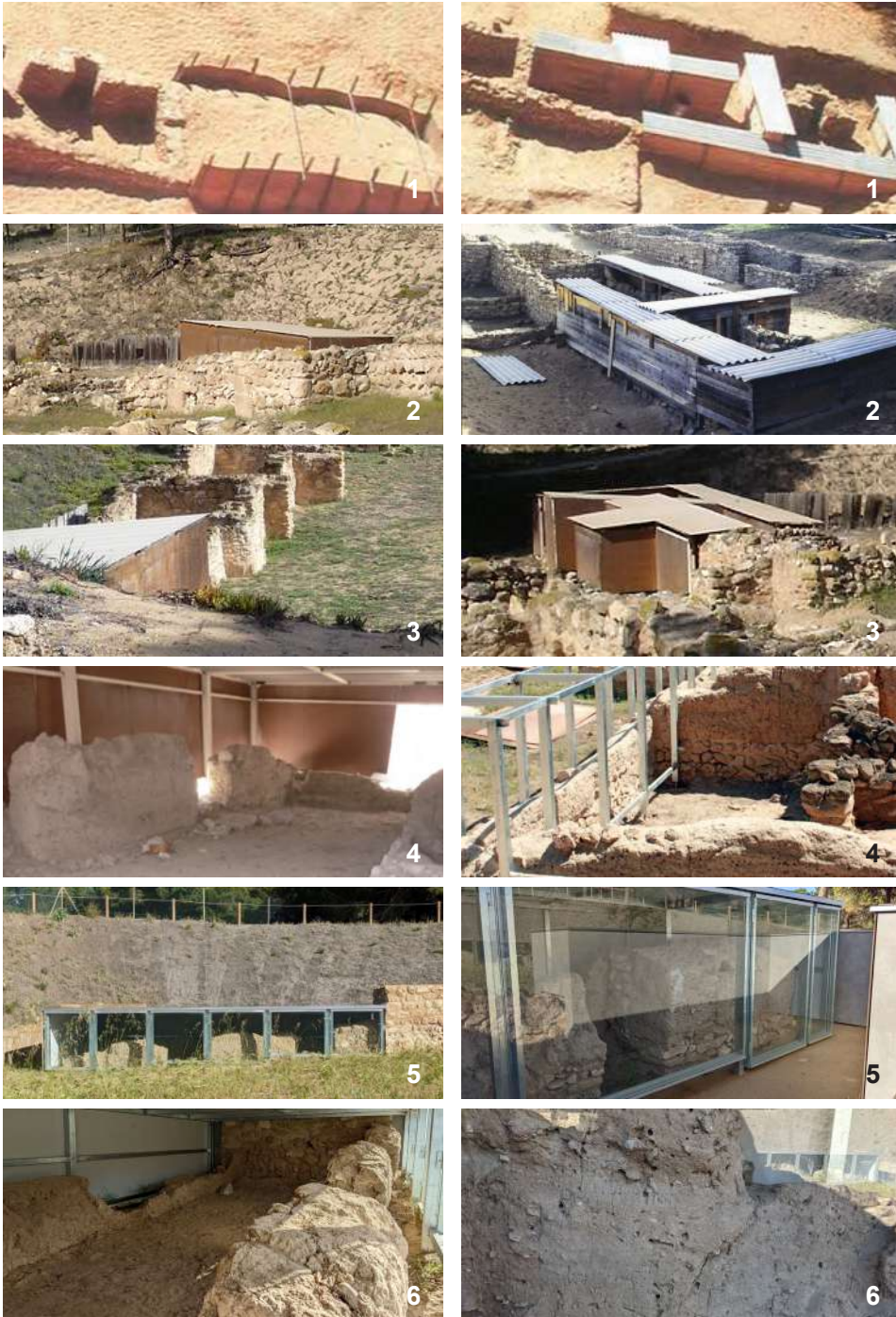
Figura 10.128-10.133. Evolución de las estructuras de tierra del ámbito M XXII (E-IV y E-III), bajo su re-enterrado en 1989 (1), cubierta temporal en 2006 (2), 2012 (3) y 2013-14 (4); y permanente parcial en 2022, desde el exterior (5) e interior (6).
