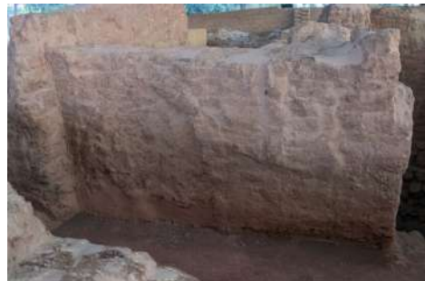
Figura 6.28. Reparación de base de muro de Cancho Roano (Zalamea de la Serena, 2022).
