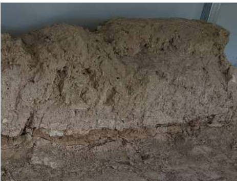
Figura 5.18. Socavación de base y ataluzado en la Rábida Califal (Guardamar del Segura, 2022).
