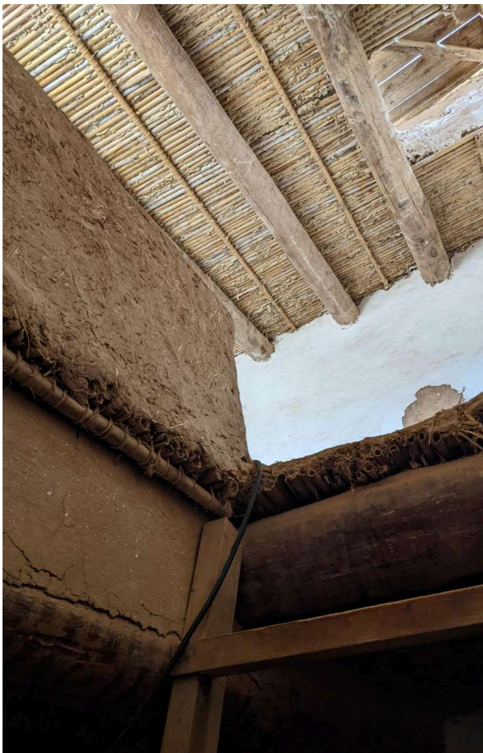
Figura 12.01. Reconstrucción integral de viviendas de tierra en la ciudad ibérica de Calafell (Calafell, 2022).
