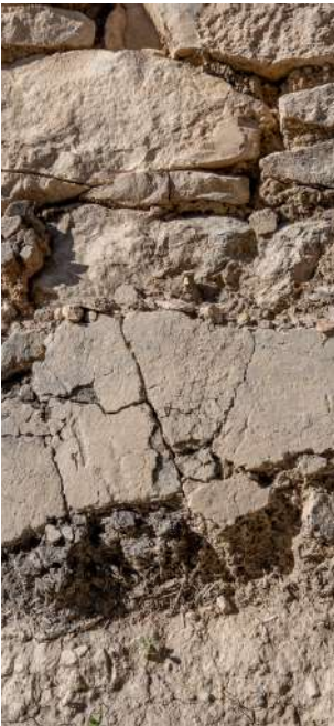
Figura 3.25. Revestimiento de tierra ibérico en el yacimiento arqueológico del Coll del Moro (Gandesa, 2023).
