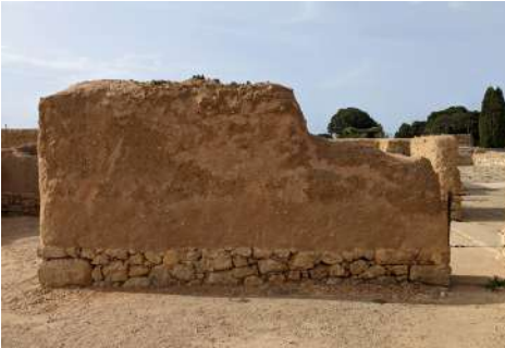
Figura 9.68. Restauración en tapias del yacimiento de Ampurias (San Martín de Ampurias, 2022).
