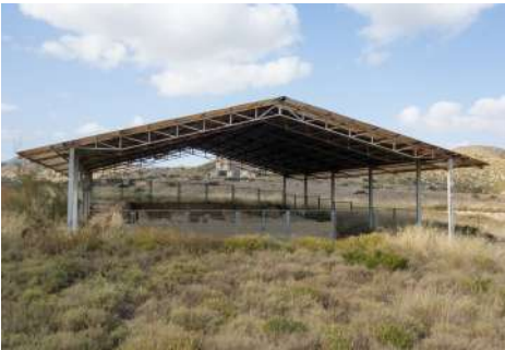
Figura 9.130. Cubierta permanente total en la mezquita del Cortijo del Centeno (Lorca, 2022).
