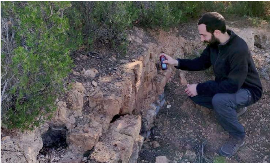
Figura 2.15. Toma de datos in situ a través de las diversas visitas técnicas realizadas a los casos de estudio seleccionados.
