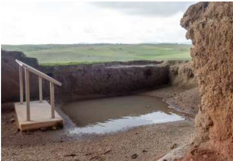
Figura 6.19. Inundación de estancias adyacentes a estructuras en La Mata (Campanario, 2022).
