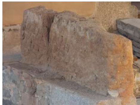
Figura 5.15. Oquedad de escorrentía por filtración en cubierta de la Casa del Mitreo (Mérida, 2022).
