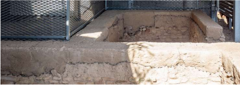
Figura 9.64. Restauración de muros de tierra con materiales similares, señalando el volumen reintegrado por tonalidad y separadores, en el yacimiento arqueológico de Cástulo (Linares, 2023).
