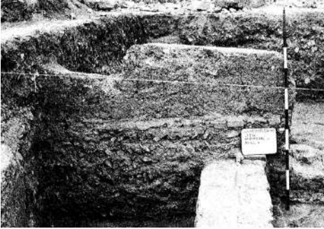
Figura 10.105. Vista del muro de tapia parcialmente desprotegido de Los Torrejones (Yecla, 1988).
