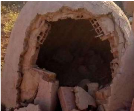
Figura 5.38. Destrucción antrópica de reconstrucción en Kelin (Caudete de las Fuentes, 2018).
