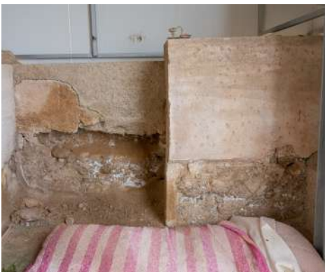
Figura 5.40. Intervenciones de hormigón e incremento de peso en Medina Siyasa (Cieza, 2022).
