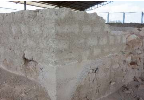
Figura 9.89. Reconstrucción de mayor dureza en la mezquita del Cortijo del Centeno (Lorca, 2022).
