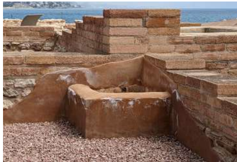
Figura 9.44 y 9.45. Estado previo al encapsulado (izquierda, 1985), y tras el mismo (derecha, 2022), de la plataforma esquinera de la Illa dels Banyets (El Campello), afectada por eflorescencias.
