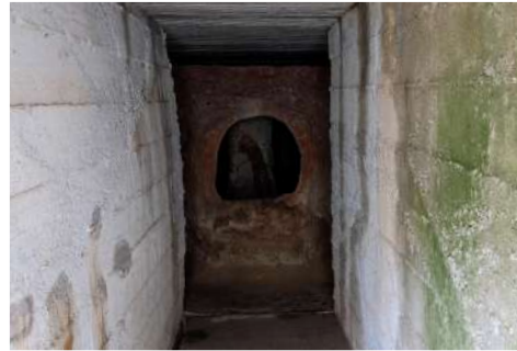
Figura 9.137. Edificio contenedor bajo calzada del horno Clos Miquel (St. Miquel de Fluvià, 2022).
