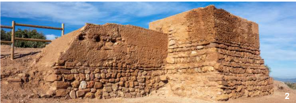
Figura 9.70. Restauración de las tapias y mamposterías islámicas en la zona arqueológica del castillo de La Vilavella (Castellón, 2018-2021), atendiendo a los criterios internacionales, materiales y técnicos.
