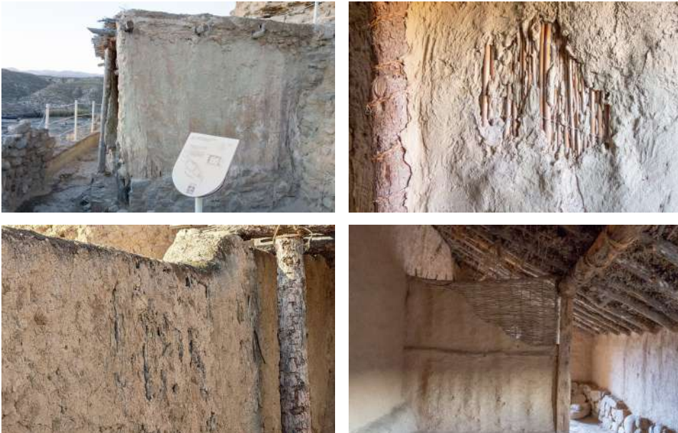
Figura 3.32-3.35. Extracto de reconstrucciones ejecutadas con técnicas mixtas de tierra en yacimientos arqueológicos peninsulares: Arriba: Castellón Alto, caña cosida (Granada, 2022); Abajo-izquierda: Los Millares (Almería, 2022); Abajo-derecha: Numancia, caña trenzada/encestado (Soria, 2022).
