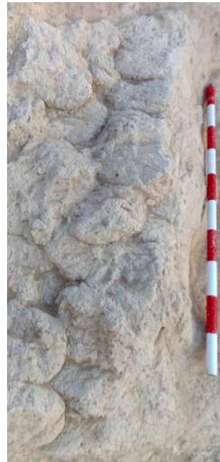
Figura 3.27. Muro amasado (edad de Bronce) por apilamiento de bloques de tierra en el yacimiento Caramoro I (Alicante, 2018).
