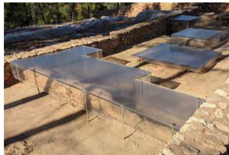
Figura 9.123. Cubierta parcial sobre elementos domésticos y muros de La Celadilla (Ademuz, 2021).
