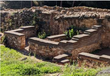
Figura 9.85. Reconstrucción in situ con ladrillo cerámico en La Fonteta (Guardamar del Segura, 2022).
