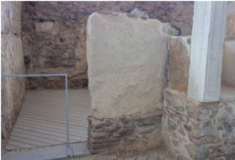
Figura 9.46. Encapsulado de adobes en estructuras de El Molinete (Cartagena, 2022), bajo cubierta.
