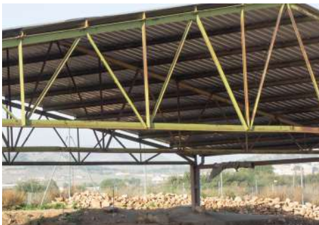
Figura 10.113 y 10.114. Necesidades de mantenimiento para cubiertas, cuyo proceso de oxidación y corrosión resulta en el teñido de los restos por filtración y escorrentía de agua (Yecla, 2022).
