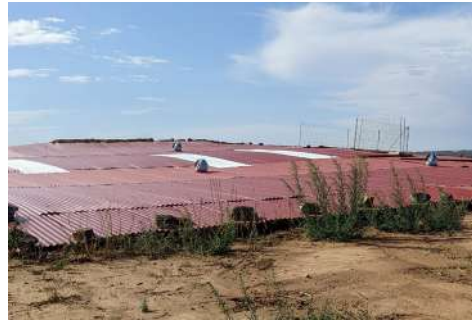
Figura 9.117. Cubierta de trabajo con chimeneas en las Casas del Turuñuelo (Guareña, 2022).
