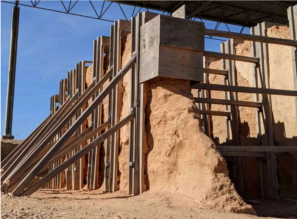
Figura 5.35. Estabilización estructural mediante apeo y apuntalado en muros del denominado gran edificio de adobe en Contrebia Belaisca (Botorríta, 2022).
