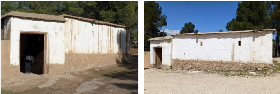
Figura 9.98 y 9.99. Evolución de la reconstrucción cubierta y ex situ de la vivienda ibérica de adobe en la Bastida de les Alcusses (Moixent). Estado previo (izquierda, 2010) y actual (derecha, 2022).
