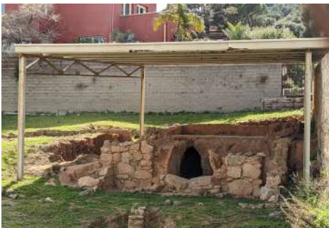
Figura 9.120. Cubierta permanente parcial en el horno de Ca L'Arnau (Cabrera de Mar, 2022).
