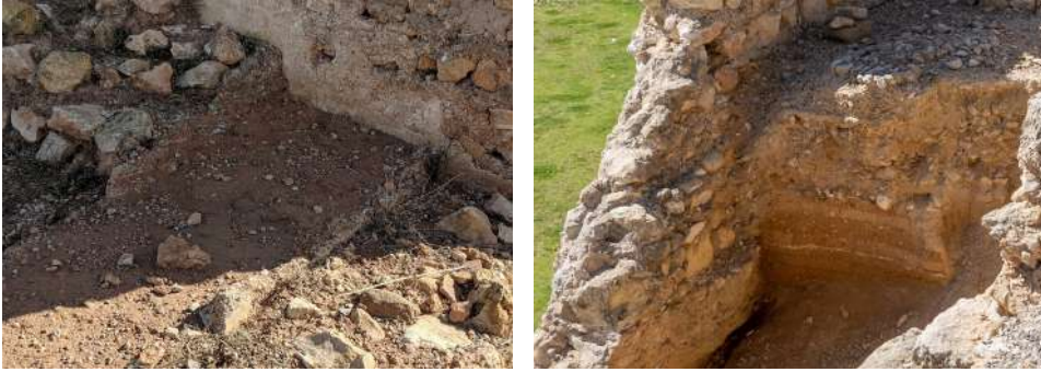
Figura 1.08 y 1.09. Tapia calicostrada defensiva en la alquería de Bofilla (izquierda, Bétera, 2021) y adobes en la muralla de Tarraco (derecha, Tarragona, 2023) fuera del ámbito de estudio de la investigación.
