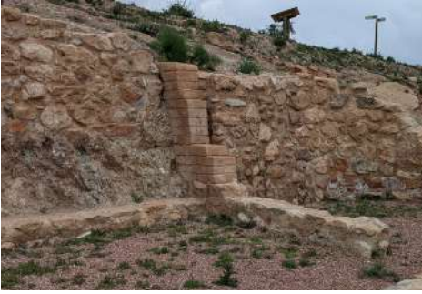
Figura 9.79. Reconstrucción in situ de mayor dureza en Peña Negra (Crevillente, 2022).
