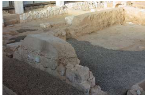
Figura 6.12. Zócalo de mampostería en estancias de la Casa de los Grifos (Alcalá de Henares, 2022).
