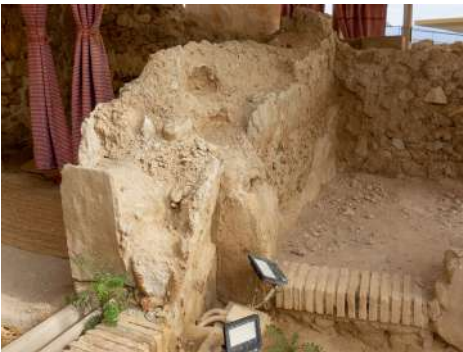
Figura 3.56. Muros de tapia con brecas de yeso y tierra en viviendas islámicas del yacimiento arqueológico de Medina Siyasa (Murcia, 2022).
