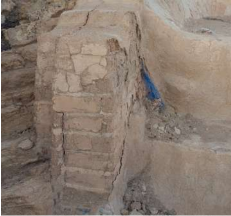
Figura 5.32. Desconexión de hiladas en Plaza de los Moros (Villatobas, 2022).
