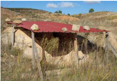
Figura 9.114. Cubierta temporal sobre hornos de adobe en el Mas del Moreno (Foz Calanda, 2022).
