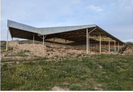
Figura 9.126. Cubierta permanente total en el yacimiento de Lépidia Celsa (Velilla de Ebro, 2022).
