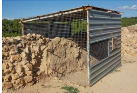
Figura 9.113. Cubierta temporal sobre revestimiento y estructuras de la Lloma de Betxi (Paterna, 2022).
