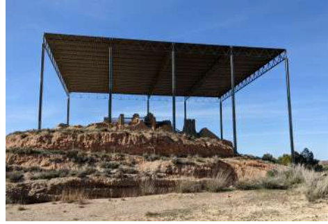
Figura 9.127. Cubierta permanente total en el yacimiento de Contrebia Belaisca (Botorríta, 2022).
