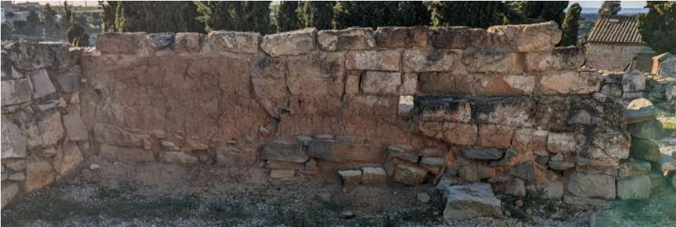
Figura 9.58. Consolidación química mediante proyección de silicato de etilo en el yacimiento arqueológico del Turó del Calvari (Villalba de los Arcos, 2022).
