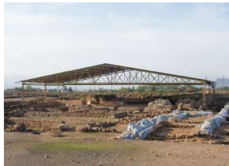
Figura 10.104. Cubierta metálica de 1988 en la villa romana de los Torrejones (Yecla, 2022).
