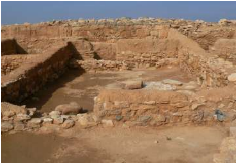
Figura 9.40 y 9.41. Encapsulado y protección de muros de adobe en el yacimiento del Tos Pelat (Moncada), con regularización de aristas, alteración visual y manchas de humedad (derecha, 2022).
