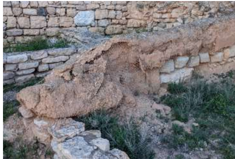
Figura 9.47. Encapsulado de muros en estado de degradación en Lépidia Celsa (Velilla de Ebro, 2022).
