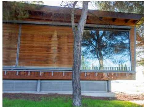
Figura 8.41. Ventilación perimetral en el contenedor del Cerro de la Mota (Medina del Campo, 2022).
