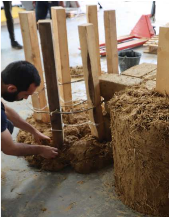
Figura 2.34 y 2.35. Ejecución de muros de amasado y adobe para hipotética vivienda antisísmica durante el taller de arqueología experimental del XXI Festival Grains d'Isère , Villefontaine (Francia).
