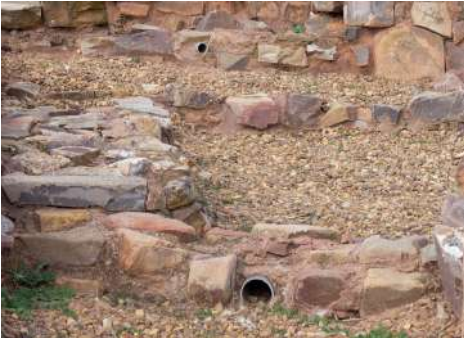
Figura 9.26. Drenaje superficial entre estancias en el Cerro de las Cabezas (Valdepeñas, 2022).
