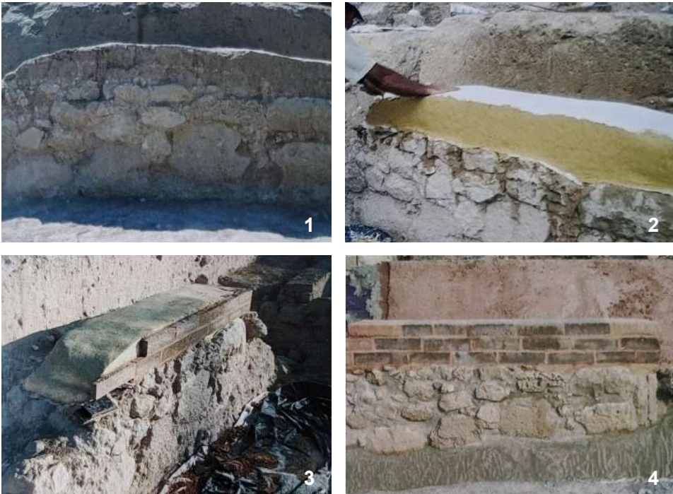
Figura 9.52-9.55. Encapsulado con simulación de aparejo a través de plaquetas cerámicas, durante su ejecución (2001) y tras la misma (2001), en el yacimiento arqueológico del Tossal de Manises (Alicante).
