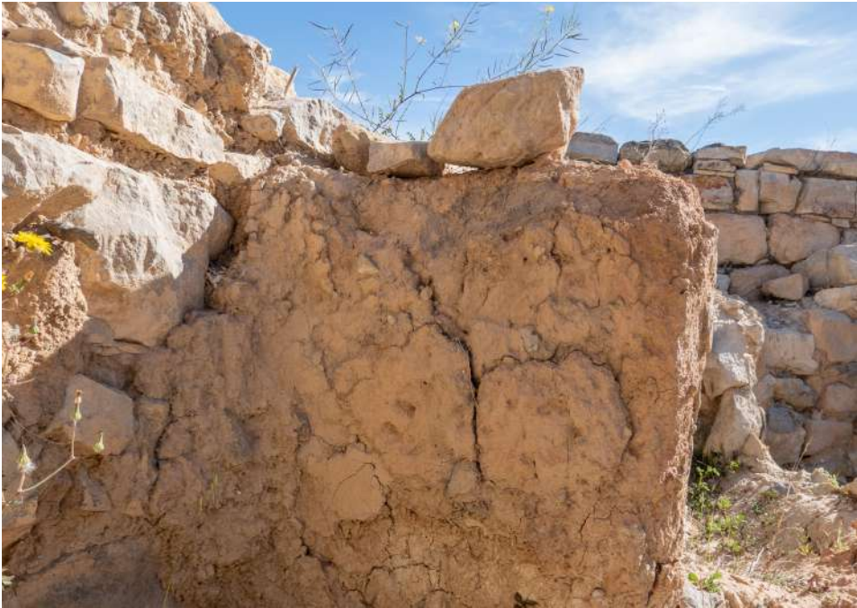
Figura 9.32. Sombrero de muro mediante el reposo de piedras sobre coronación, evitando el golpeo directo de la lluvia, en el yacimiento del Coll del Moro (Gandesa, 2023).
