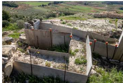
Figura 9.15. Re-enterrado confinado de elementos de tierra en el Coll del Moro (Gandesa, 2022).
