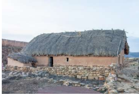
Figura 9.72. Reconstrucción in situ integral de vivienda de adobe en Numancia (Garray, 2022).
