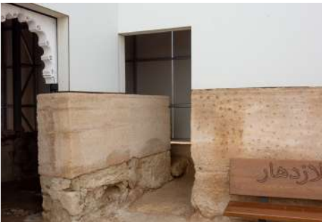
Figura 9.93. Reconstrucción in situ con hormigón en Medina Siyasa (Cieza, 2022).
