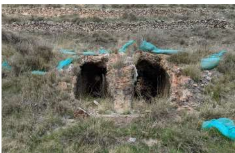
Figura 6.55. Estado previo al incendio del horno de La Oruña (Vera del Moncayo, abril de 2022).
