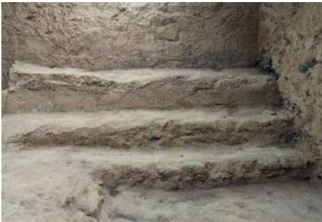
Figura 4.18. Gradas de adobe en el yacimiento de Las Casas del Turuñuelo (Guareña, 2022).
