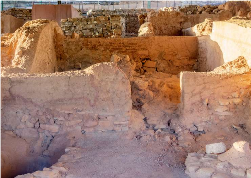
Figura 9.65. Restauración de muros de adobe con materiales y técnicas similares, señalando el volumen reintegrado mediante líneas rojas perimetrales, en el yacimiento del Cerro de la Cruz (Almedinilla, 2022).
