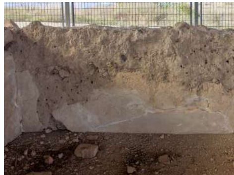
Figura 3.57. Muros de tapia de tierra en construcción islámica del yacimiento arqueológico de la Mezquita del Cortijo del Centeno (Murcia, 2022).
