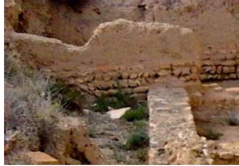
Figura 10.106. Vista del muro de tapia parcialmente desprotegido de Los Torrejones (Yecla, 2014).
