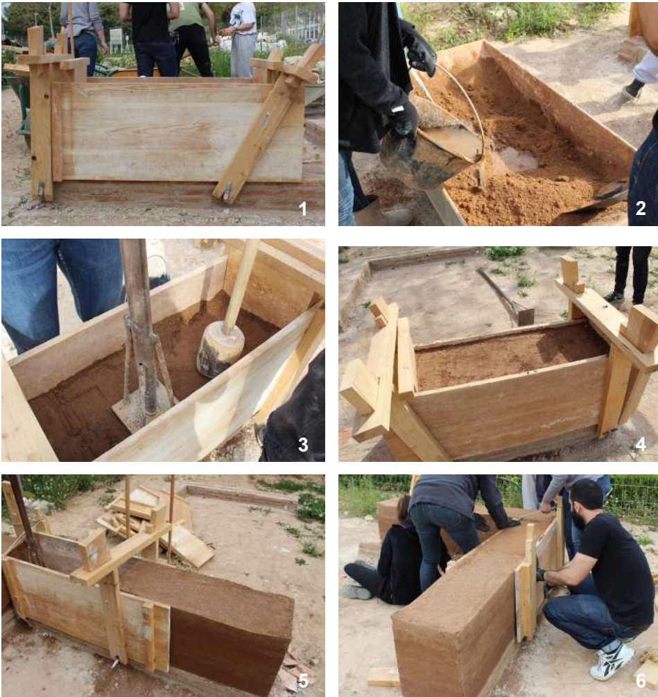
Figura 3.52. Proceso de ejecución de diferentes tipologías de tapia durante el taller de arquitectura experimental del proyecto RISK-Terra, Valencia (España): 1. Preparación de encofrado; 2. Mezcla de áridos e hidratación; 3. Vertido y pisado/compactación de tongadas; 4. Colmatación de encofrado; 5. Traslado de encofrado; 6. Desencofrado de la estructura completada.
