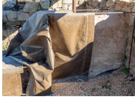
Figura 9.106. Cubrimiento con lona en muro del Turó d'en Roina / Can Taco (Montornès del Vallès, 2022).
