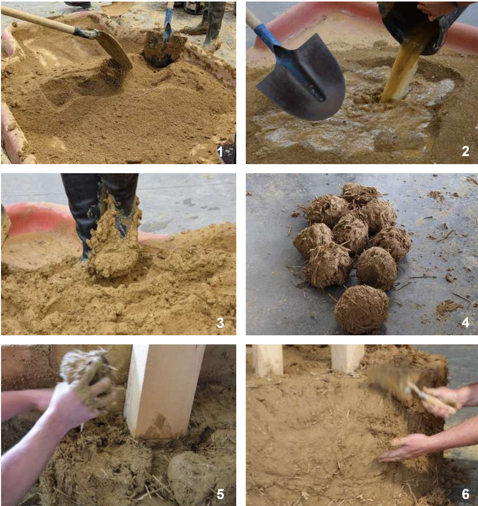
Figura 3.21. Proceso de ejecución de un elemento de amasado durante el taller de arqueología experimental del XXI Festival Grains d'Isère, Villefontaine (Francia): 1. Dosificación y mezcla de áridos; 2. Adición del agua; 3. Proceso de mezcla y adición de fibras; 4. Preparación de bolas de aplicación; 5. Aplicación de las pelladas; 6. Aplomado manual con herramienta y preparación para revestimiento.
