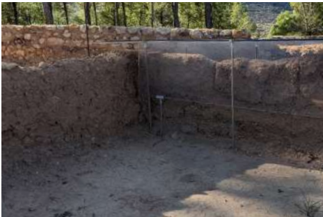
Figura 6.11. Ausencia de zócalo en estancias de La Celadilla (Ademuz, 2021).
