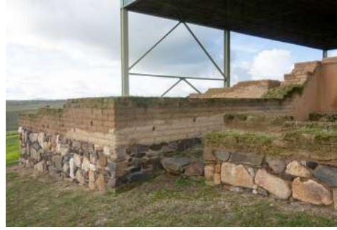
Figura 9.88. Reconstrucción in situ de adobes de mayor dureza en La Mata (Campanario, 2022).
