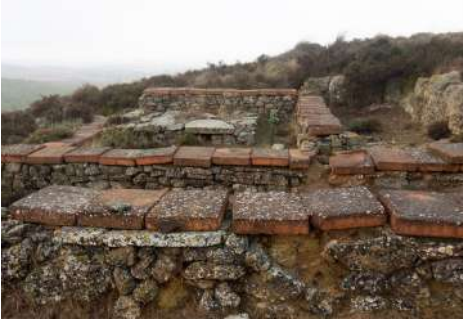
Figura 9.87. Reconstrucción in situ de adobes de mayor dureza en El Amarejo (Bonete, 2022).
