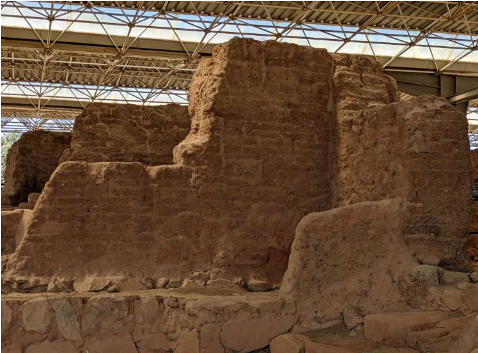
Figura 1.01. Alzados de adobe protohistóricos sobre zócalos de piedra conservados bajo cubierta en el yacimiento arqueológico de Cancho Roano (Zalamea de la Serena, 2022).
