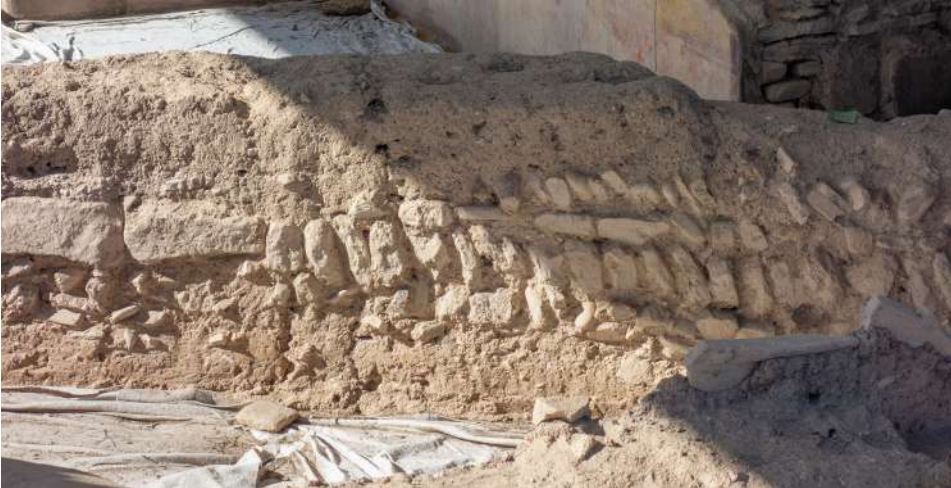
Figura 3.54. Muros de tapia en estructuras medievales al sur del del mosaico de los amores del yacimiento arqueológico de Cástulo (Jaén, 2023).
