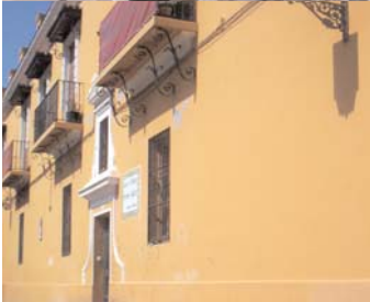
Construcciones del perímetro y del Carer Bon Pastor del Barrio de la Morería
