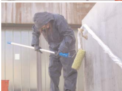
Limpieza con agua a presión y aplicación del ácido.
