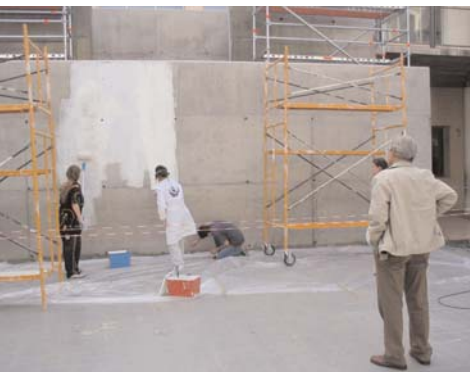
Inicio del proceso de imprimación.
