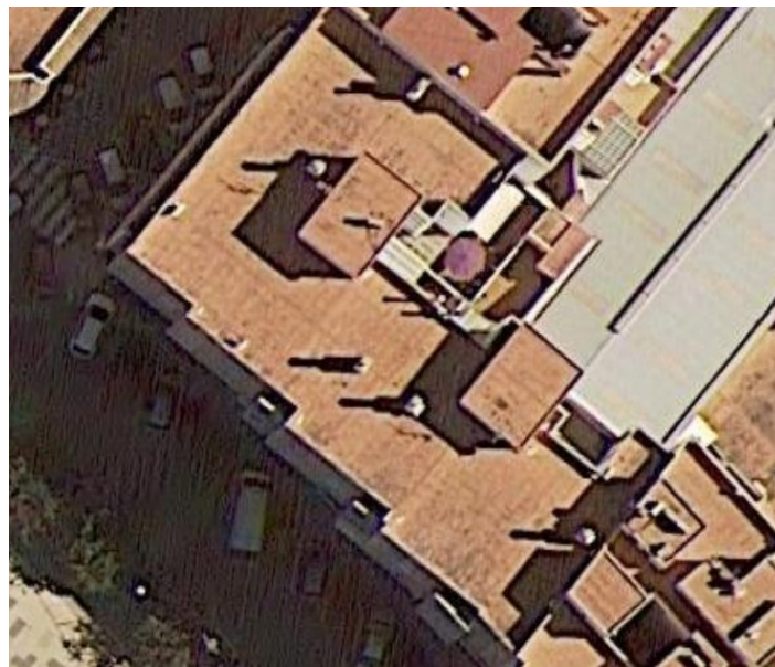
Imagen 2. Cubierta del edificio
