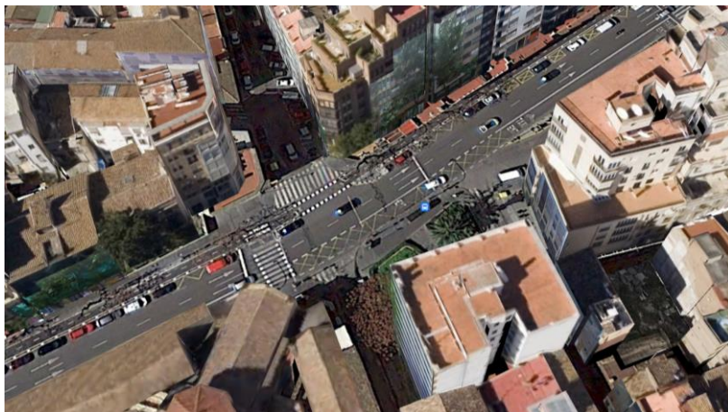
Ilustración 12. Calle Guillem de Castro con calle Lepanto fecha 03/2017
