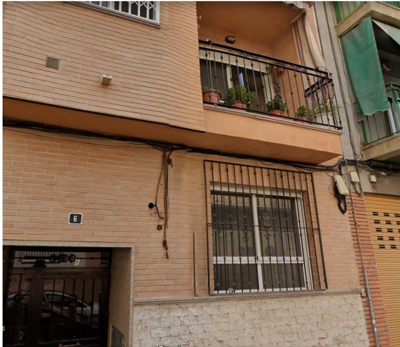
*Ilustración 27: Ejemplo real de una entrada por fachada en el portal 6 y una parte de la bajante del portal 8*
