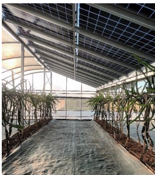
Fotog. 2: Disposición de la estructura agrivoltaica de máxima densidad con paneles solares en el cultivo de la pitahaya ( H. undatus ).
