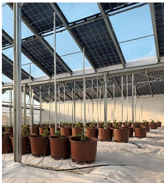
Fotog. 3: Disposición de la estructura agrovoltáica en la higuera con paneles de máxima densidad y al tresbolillo.
