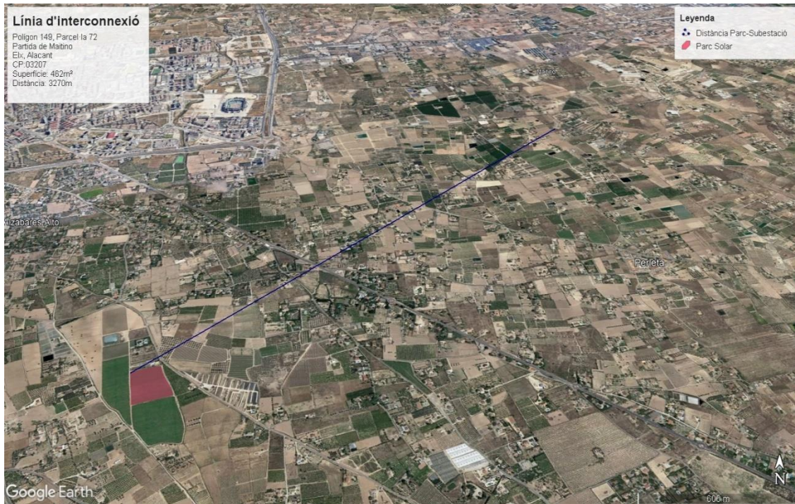
Figura 10: Vista en altura de la línia d'interconnexió del Parc Solar Elx
