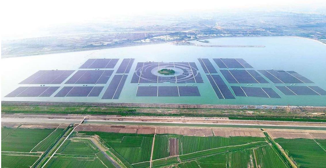
Imagen 3. Planta fotovoltaica flotante más grande del mundo. Fuente: World Trade Energy
