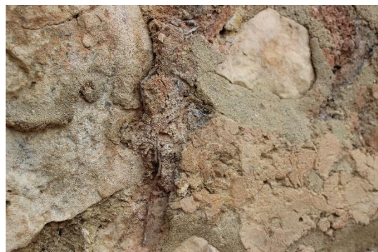
Figura 35. Detall de les restes del morter d'oli aplicat en el bisellat del revestiment. Font: Arxiu del GRAP.
