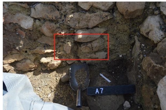
Figura 44. Detall de la zona d'extracció de les mostres de morter. Font: Fotografia de l'autora.
