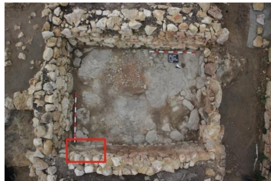
Figura 42. Localització de la zona d'extracció de les mostres de morter a l'àmbit A7. Font: Arxiu del GRAP.
