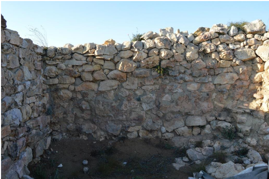
Figura 32. Estat actual de conservació de la façana interior del mur UE0005 de l'àmbit A5. Font: Fotografia de l'autora.
