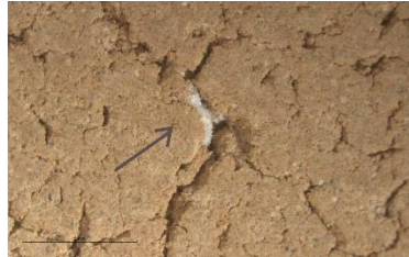
Figura 66. Detall a x10 de la superfície de la proveta M1-OL-50ARB. Font: Fotografia de l'autora.
