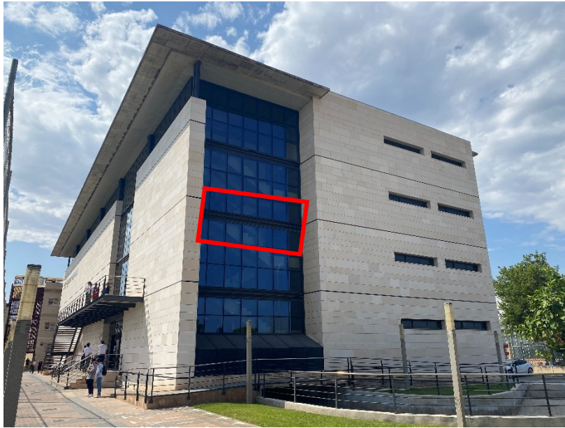
Figura 33. Fachada este del edificio con la señalización de la apertura de los huecos de entrada de aire exterior.
