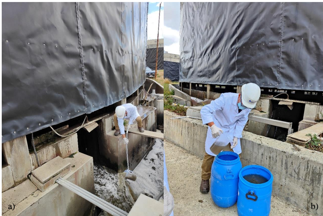
Figura 3.9. Recolección aguas de salida del filtro percolador PTAR Puchucollo, a) toma de muestras de la salida, b) obtención de sobrenadante del reactor. Fuente: Fotografía tomada por el autor
