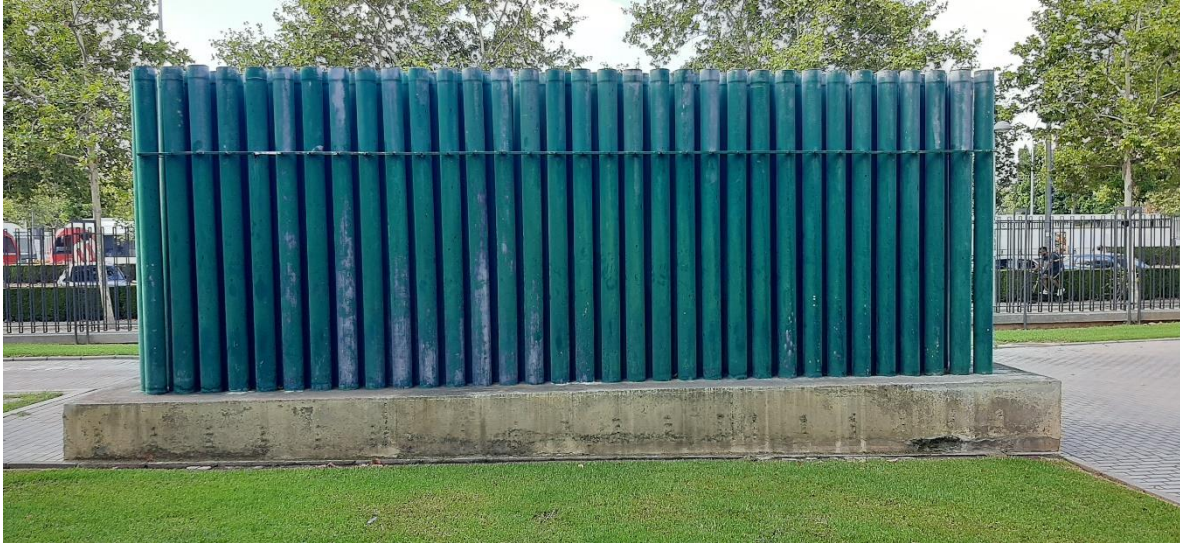
Figura 12: Pantalla acústica basada en cristales de sonido.
