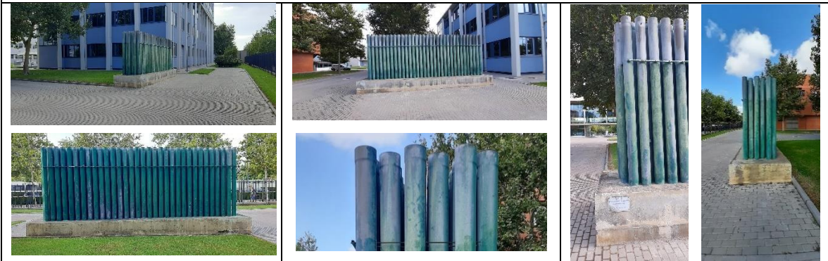
Vista del demostrador de red triangular RT1.
