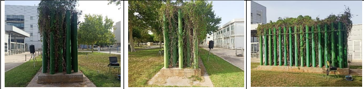
Vista del demostrador de red triangular RT2.
