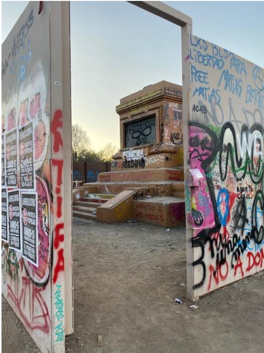
Imagen 127. Muro perimetral plinto escultura de general Baquedano, Plaza Dignidad. Foto de Autor, 2021.
