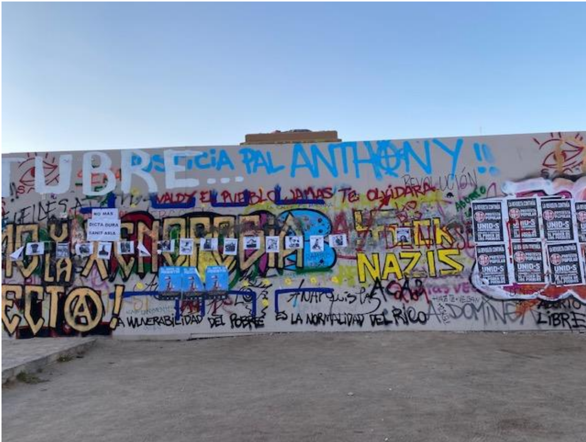
Imagen 128. Muro perimetral plinto escultura de general Baquedano, Plaza Dignidad. Foto de Autor, 2021.
