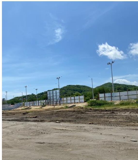
Fig. 50. Vía de acceso a playa Miramar. Fuente: Propia.
