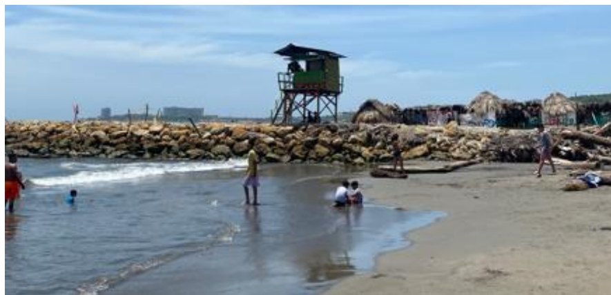
Fig. 67. Problemas de balizamiento costero en Salgar. Fuente: Propia.
