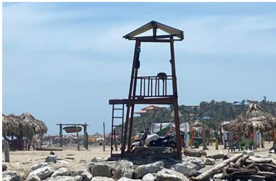
Fig. 59. Problemas de infraestructura en playas de Miramar. Fuente: Propia.
