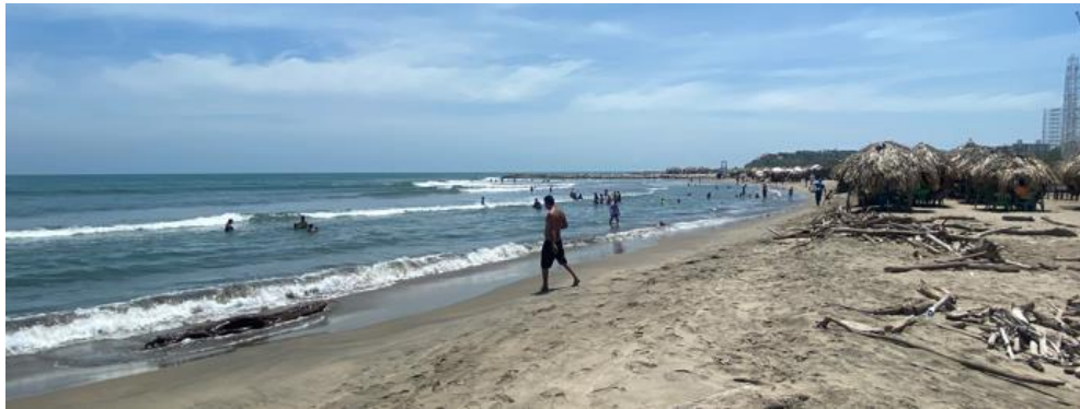
Fig. 56. Problemas de infraestructura en playas de Miramar. Fuente: Propia.
