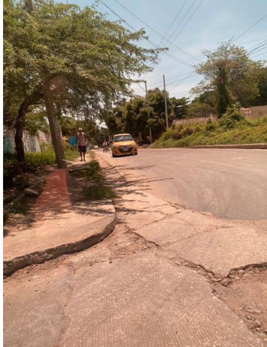
Fig. 49. Vía de acceso a carretera principal en Playa Miramar. Fuente: Propia.
