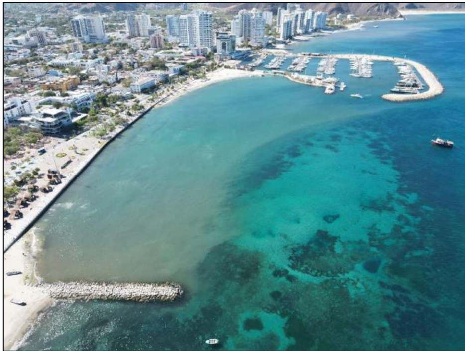
Fig. 8. Problemas de aguas servidas en Santa Marta. Fuente: W radio.
