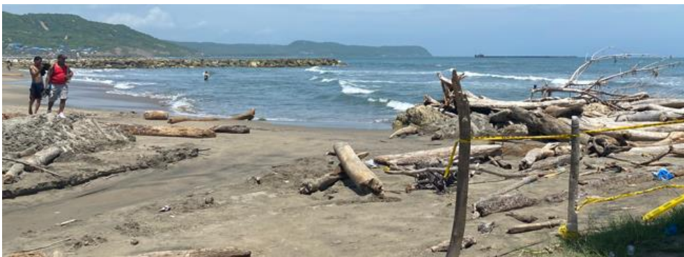
Fig. 54. Problemas de infraestructura en playas de Miramar. Fuente: Propia.
