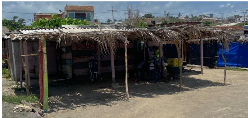
Fig. 63. Restaurante en Salgar. Fuente: Propia.
