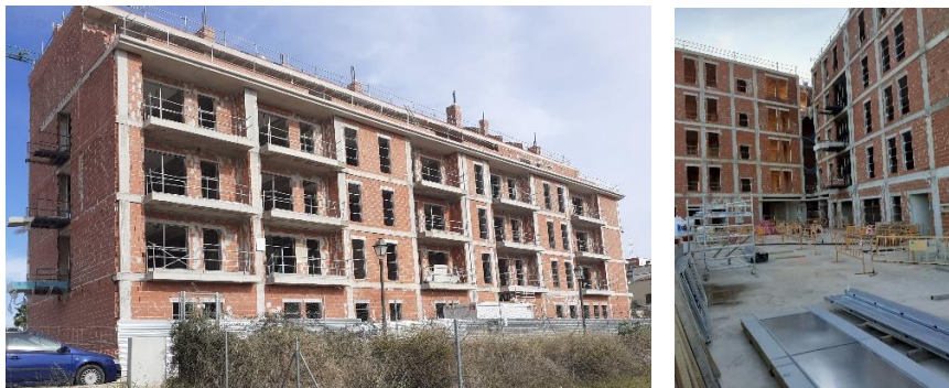
Figura 45. Etapa de acabados Fotografía de obra
