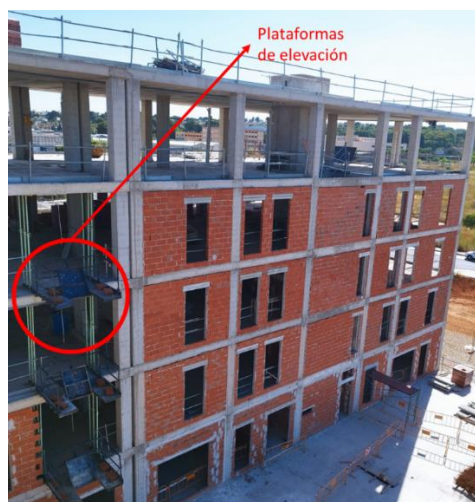
Figura 35. Imagen de plataformas de elevación y descarga en obra Elaboración propia
