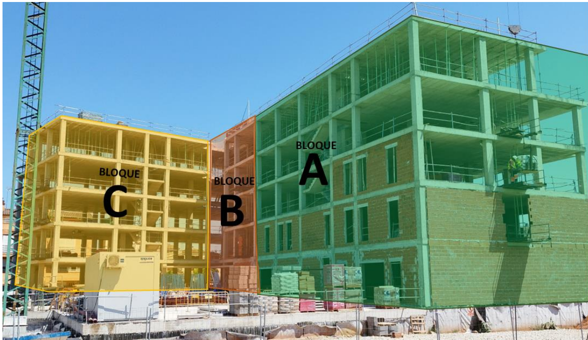
Figura 34. Fotografía etapa inicial de acabados con distribución de bloques Elaboración propia
