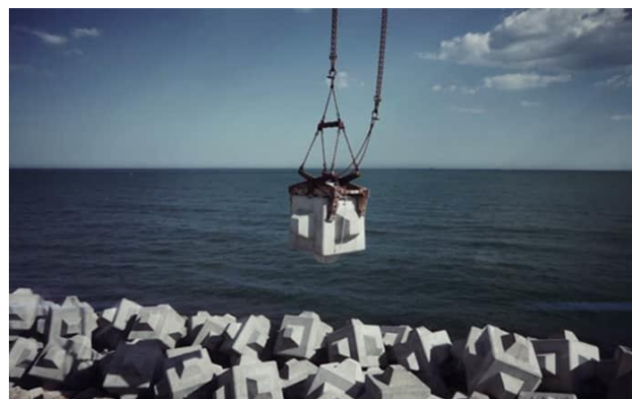
Figura 12. Colocación de cubípodos. (Fuente: Medina, J.R. & Gómez-Martín, M. E., 2015)
