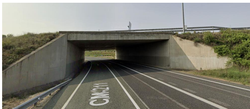
Figura 8. Paso inferior que obliga a modificar la ruta inicial (Fuente: Google Street View, 2023)
