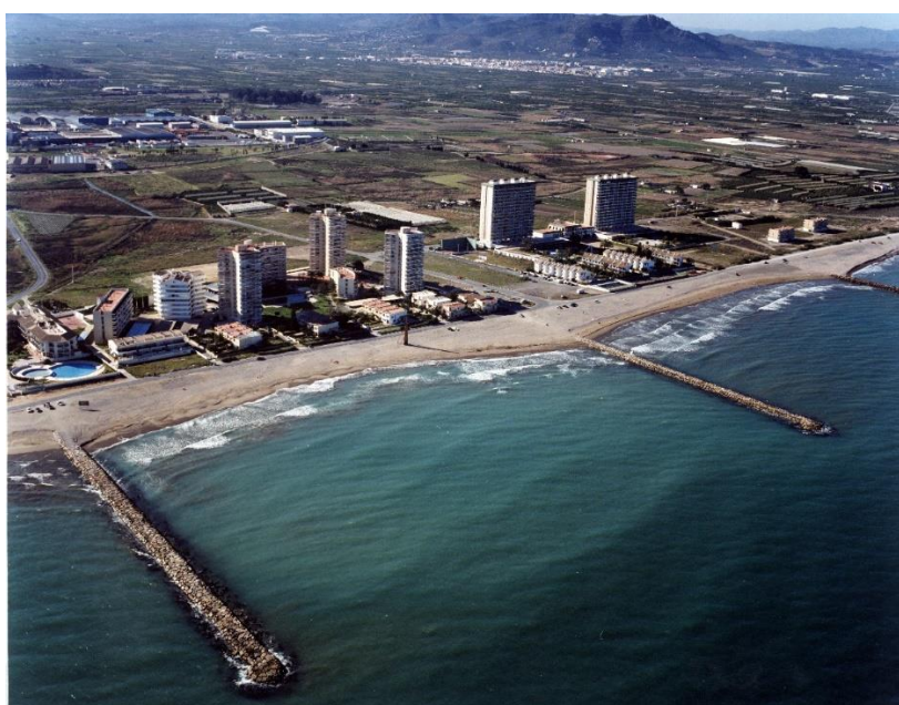
Figura 24. Estado actual de los espigones. (Fuente: GVA, 2023)
