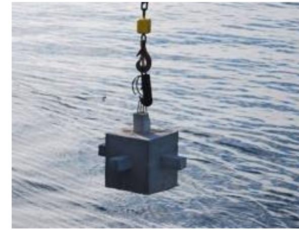
Figura 12. Ejemplo de arrecife artificial de tipo protección. (Fuente: MITECO, 2008)
