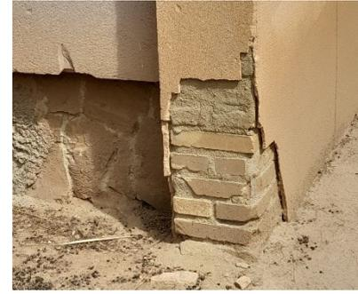
Figura 29. Falta de recubrimiento en muro portante. Caso 93311
