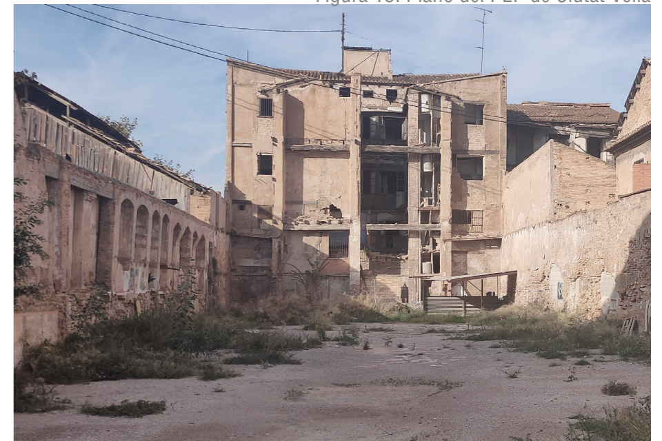
Figura 14. Fotografía interior de la zona. Elaboración propia.
