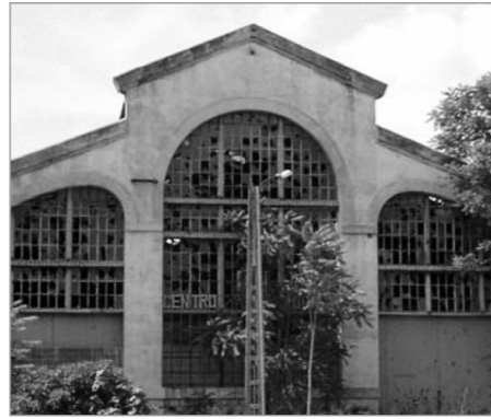
fachada norte nave I · 2012
