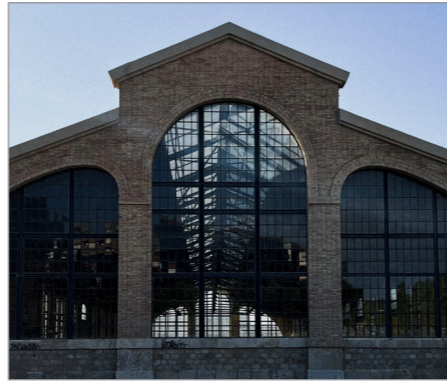
fachada norte nave I · 2022
