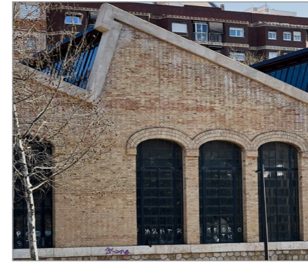
fachada oeste nave IV · 2022
