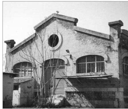
fachada este naves II - III · 2012
