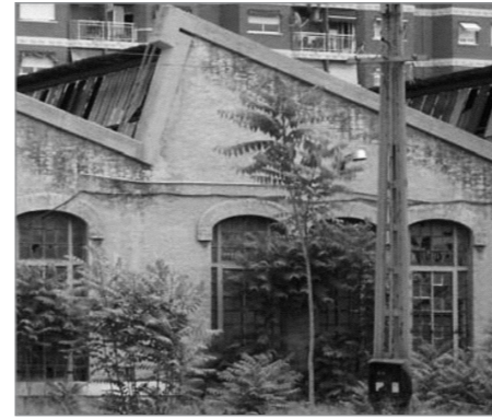
fachada oeste nave IV · 2012
