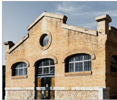
fachada este naves II - III · 2022
