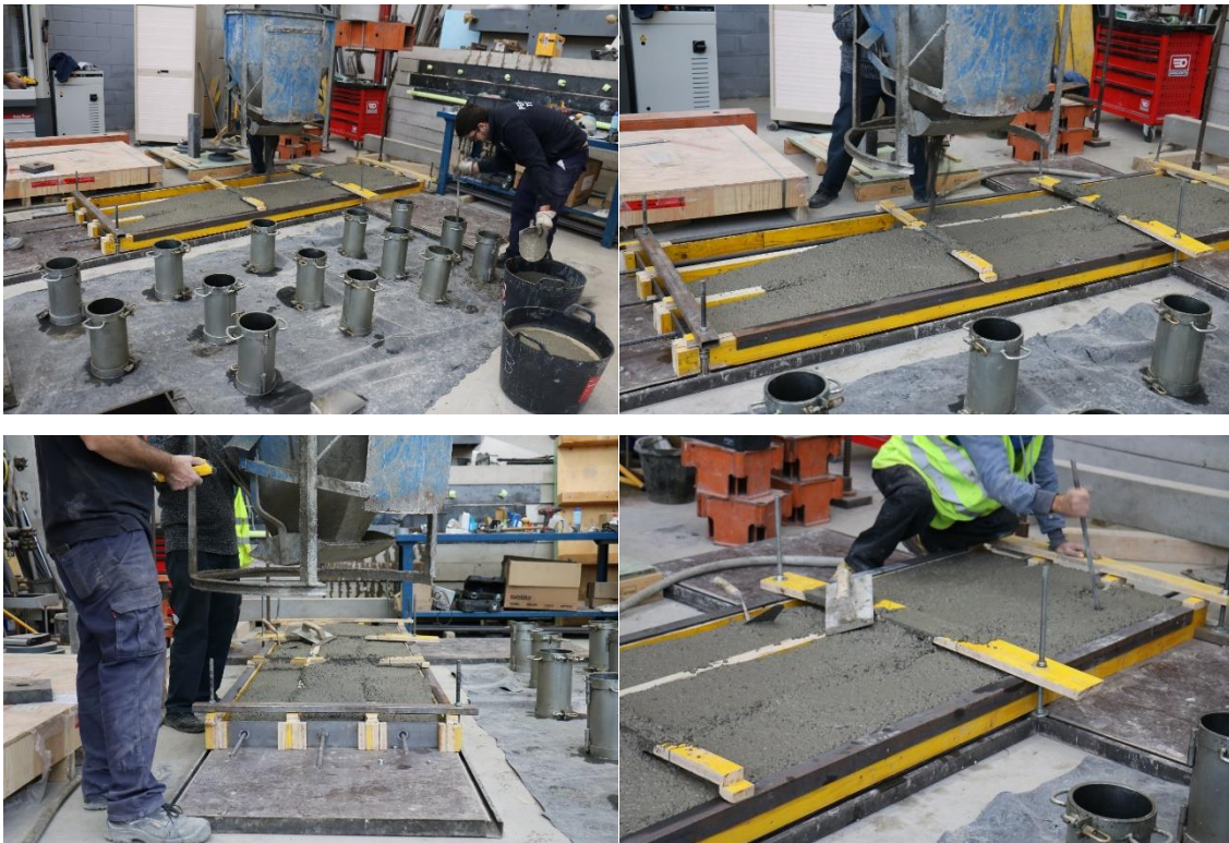
Figura. 72. Proceso de vertido y colocación del hormigón. (Fuente: Imágenes cedidas por el proyecto PREPER)
