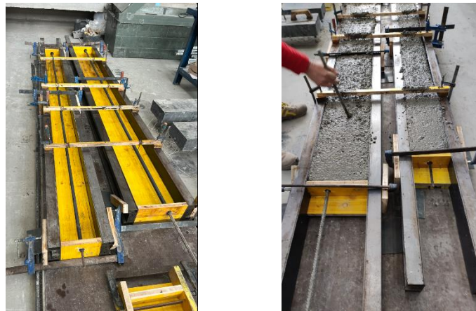
Figura. 52. Configuración de los moldes (izquierda) y proceso de colado (derecha). (Fuente: Imágenes cedidas por el proyecto PREPER).
