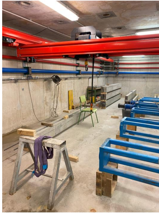
Figura. 77. Zona de acopio de las vigas realizadas. (Fuente: Elaboración propia)
