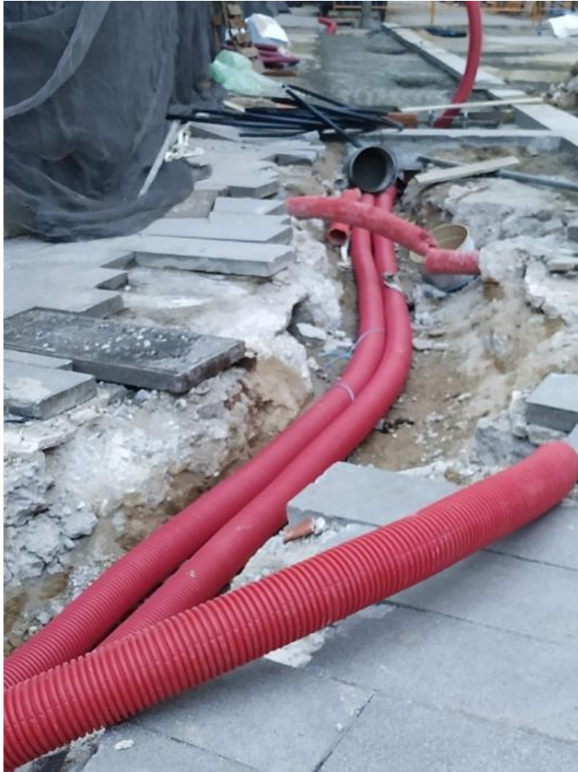
Img nº5. Fotografía de archivo personal. Tubos de protección en la instalación de fibra óptica antes de ser enterrados bajo una calle que no recuerdo entre Chueca y el Barrio de las Letras, Madrid. Capturada una tarde junio de 2020.
