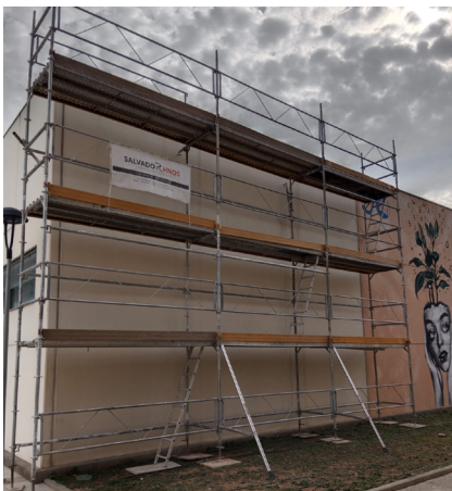
Fig. 41. Andamio preparado para la ejecución del mural
