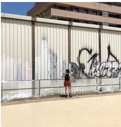
Fig. 57. Preparación del soporte lijando la superficie e imprimando
