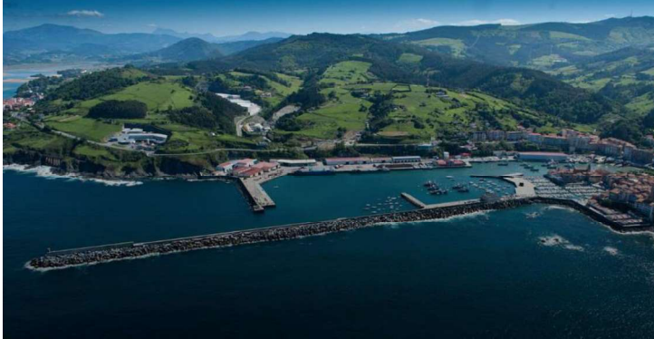
Figura 1. Vista frontal del dique de abrigo Frantxua en el puerto de Bermeo. Fuente: Puertos Deportivos de Euskadi
