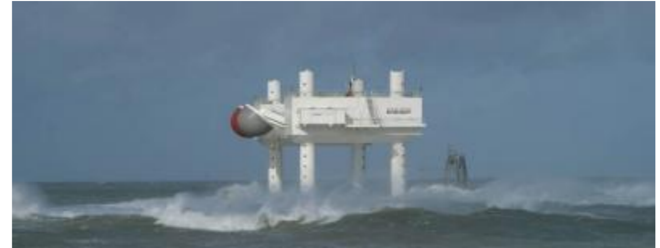
Figura 50. Flotadores levantados a causa de un temporal [34]
