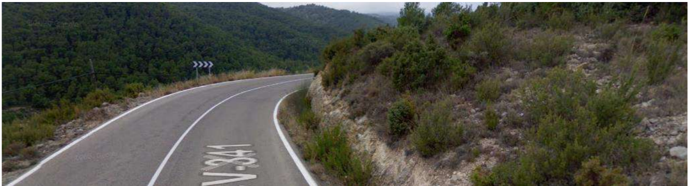
Zona de baja visibilidad con indicación de curva cerrada tramo intermedio 1 (Sentido creciente)
