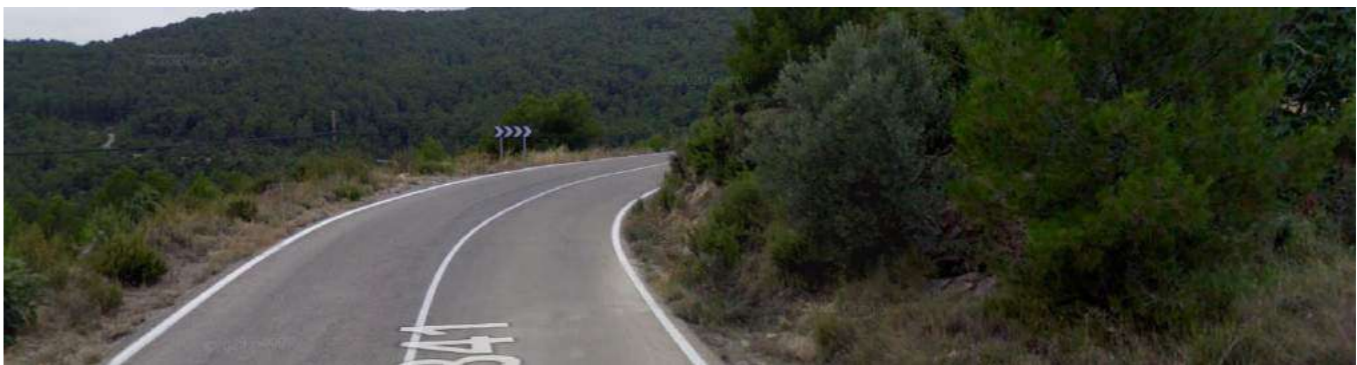
Zona de baja visibilidad con indicación de curva cerrada inicio (Sentido creciente)
