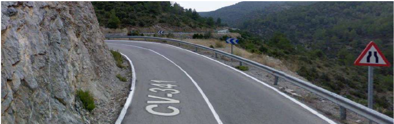
Zona de baja visibilidad (Sentido decreciente)
