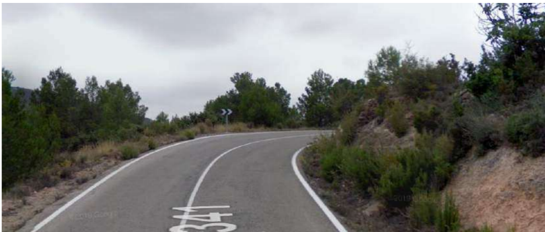
Zona de baja visibilidad (sentido creciente)
