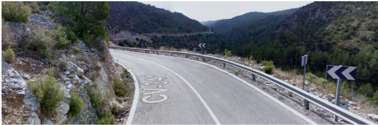
Zona de baja visibilidad (Sentido decreciente)
