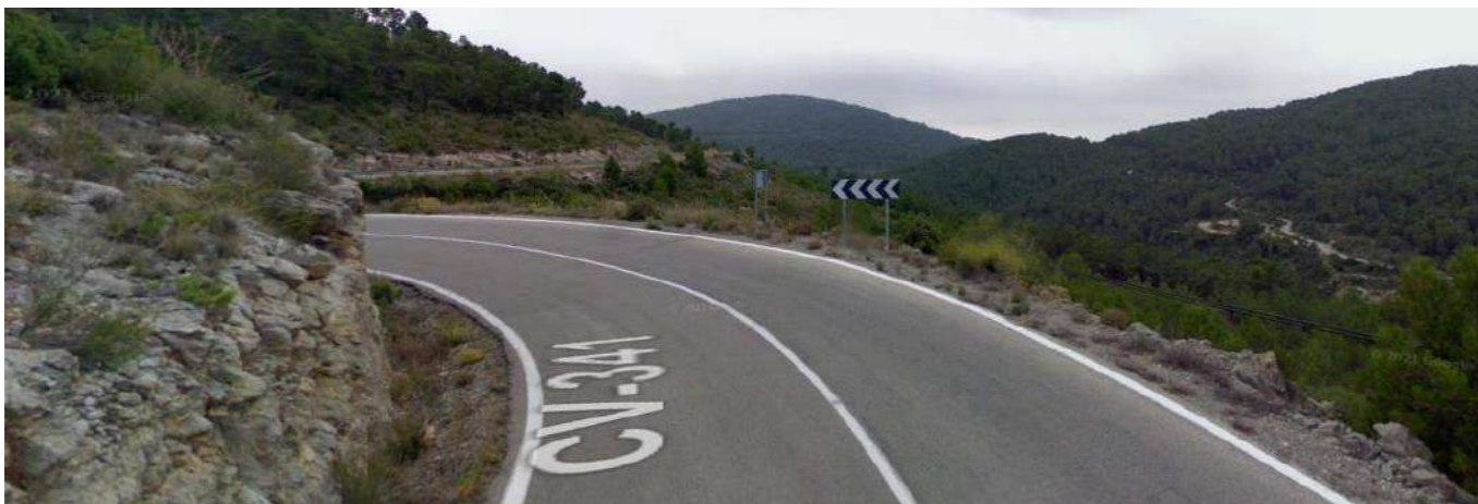
Zona de baja visibilidad (Sentido decreciente)
