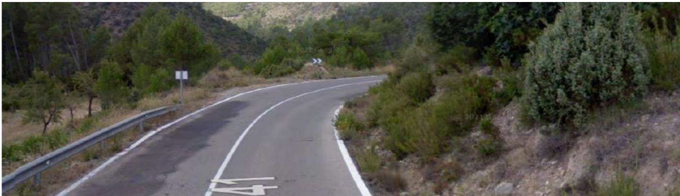
Zona de baja visibilidad (Sentido creciente)
