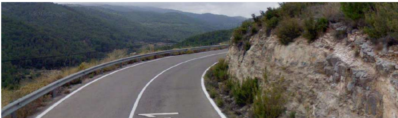
Zona de baja visibilidad con indicación de curva cerrada final (Sentido creciente)
