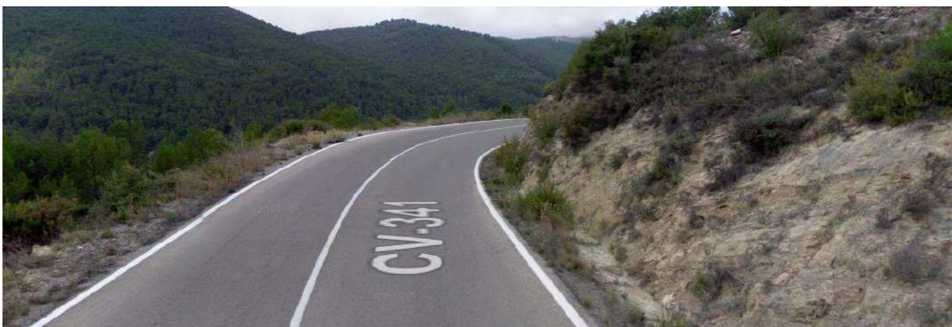
Zona de baja visibilidad (Sentido creciente)
