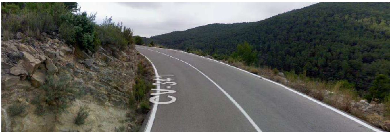
Zona de baja visibilidad (Sentido decreciente)
