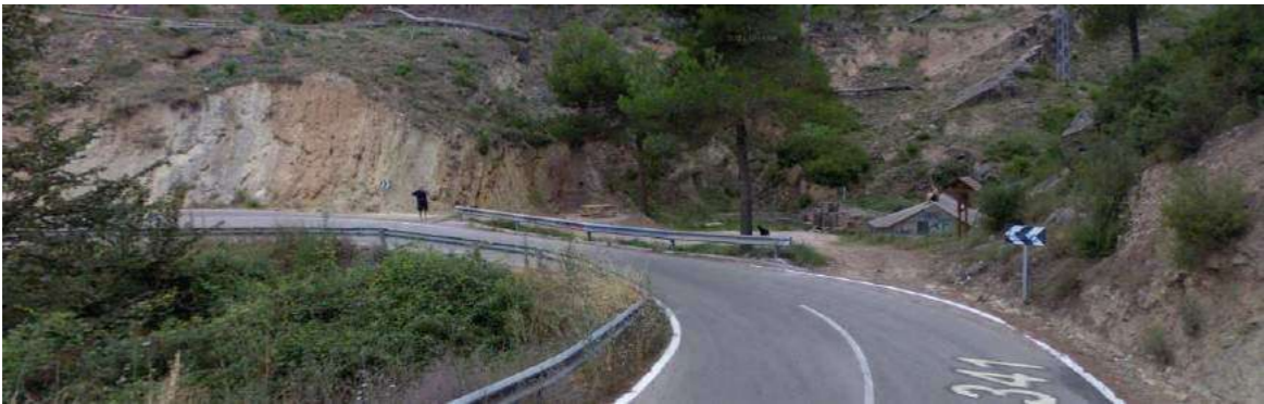
Estrechamiento en obra de paso
