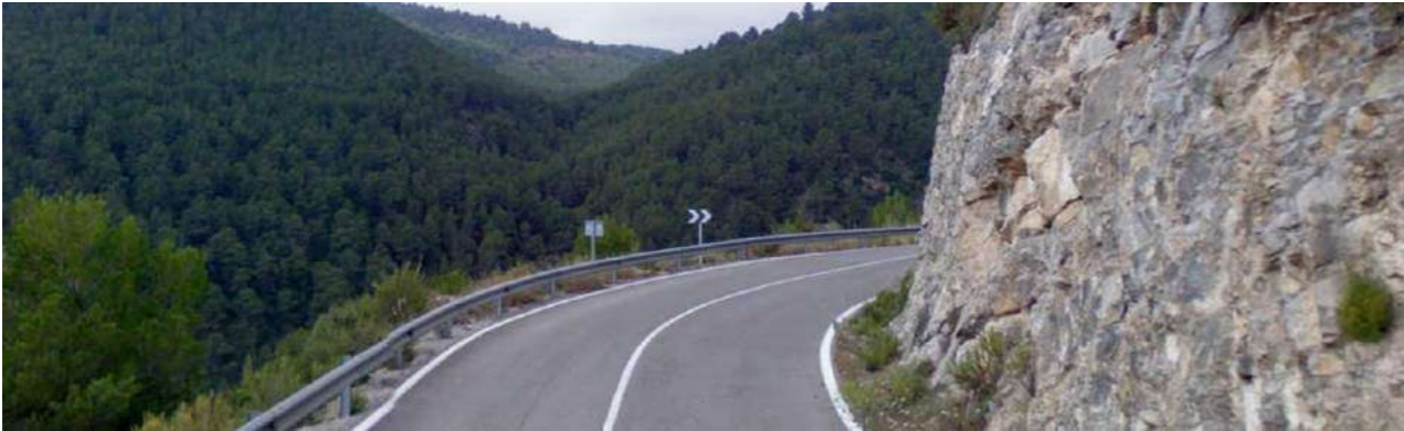
Zona de baja visibilidad (Sentido creciente)
