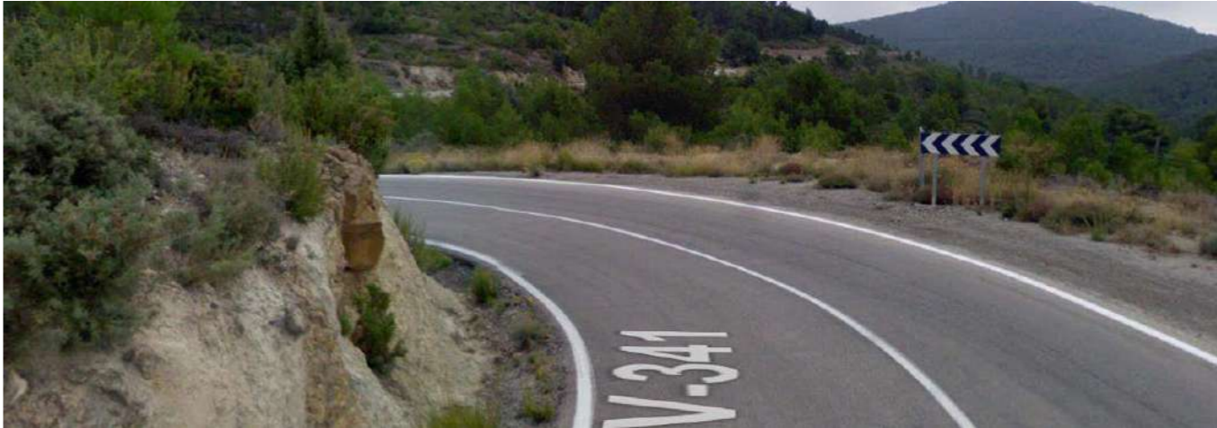
Zona de baja visibilidad (Sentido decreciente)
