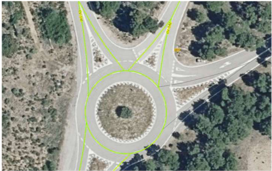
Imagen 2: Glorieta al pasar el PK 9+000 Fuente: Elaboración propia a partir de visor GVA
