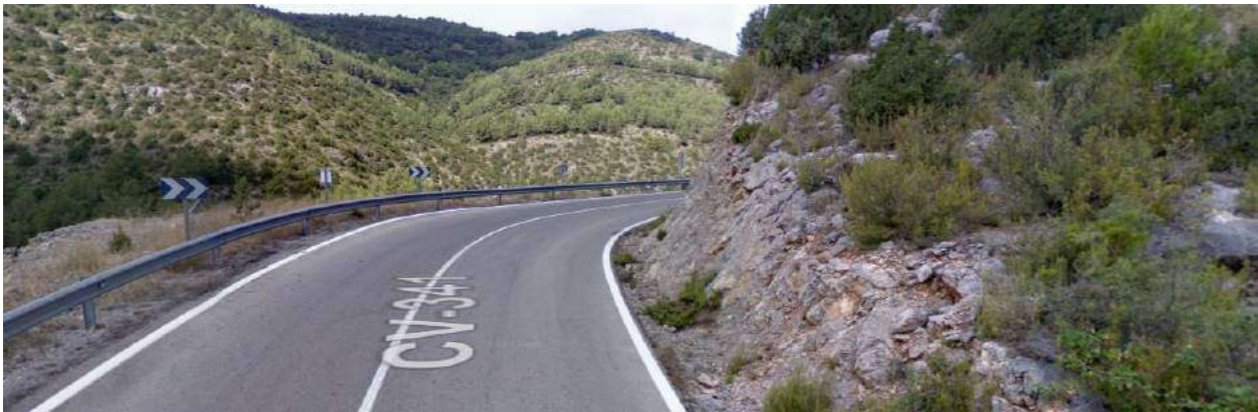
Zona de baja visibilidad (Sentido creciente)
