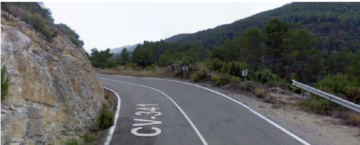
Zona de baja visibilidad (Sentido decreciente)
