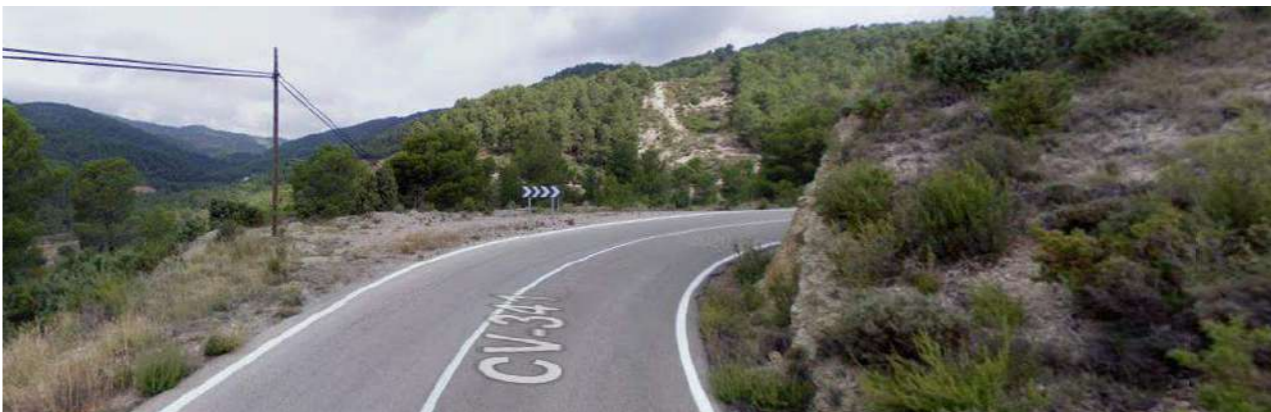
Zona de baja visibilidad (Sentido creciente)
