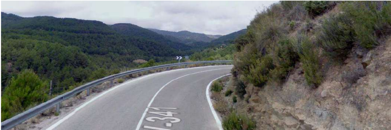
Zona de baja visibilidad (Sentido creciente)
