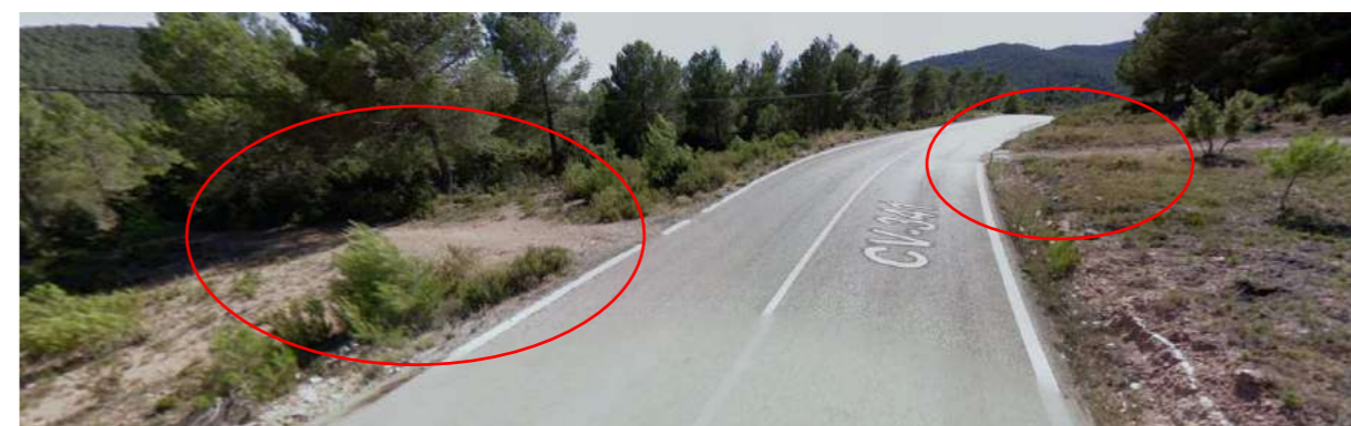
Imagen 15: Señalización de acceso del tramo 2 Fuente: Elaboración propia
