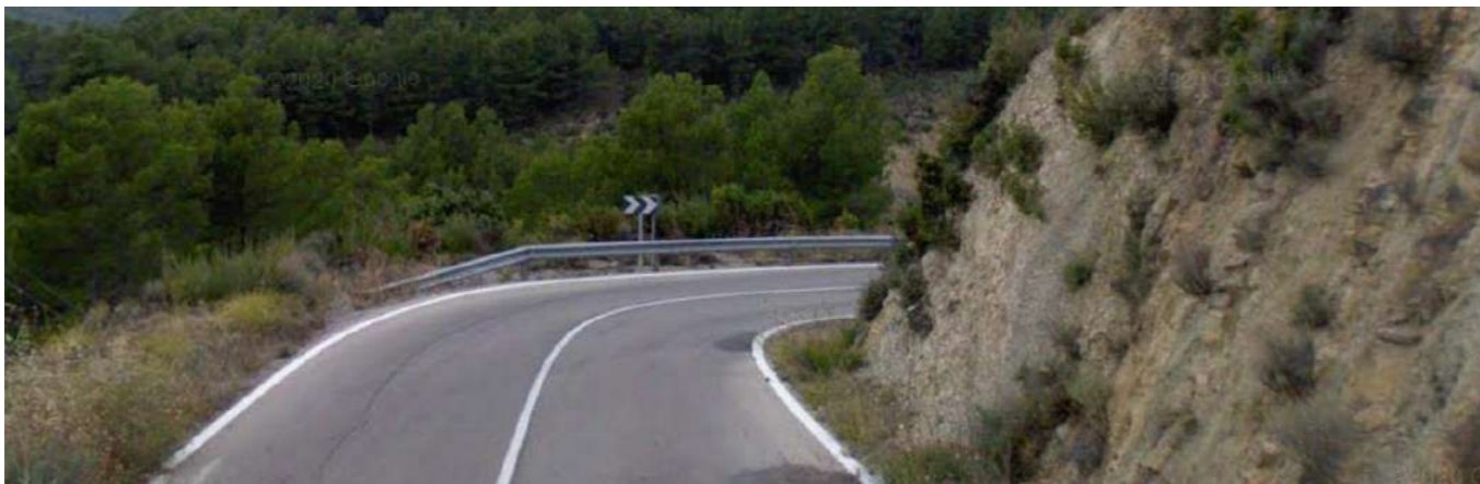
Zona de baja visibilidad con curva muy cerrada inicio (Sentido creciente)
