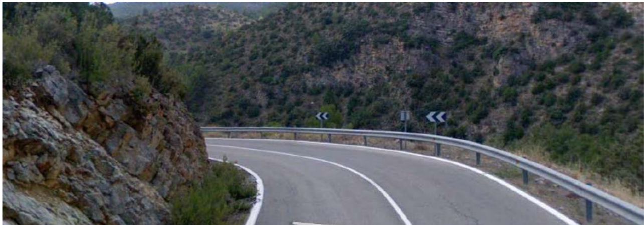
Zona de baja visibilidad (Sentido decreciente)
