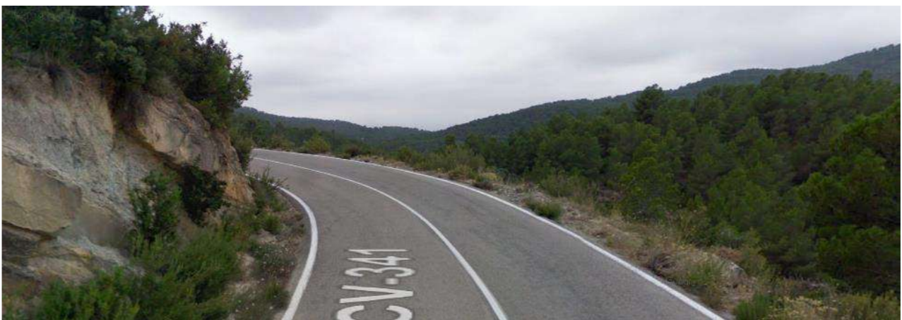
Zona de baja visibilidad (Sentido decreciente)
