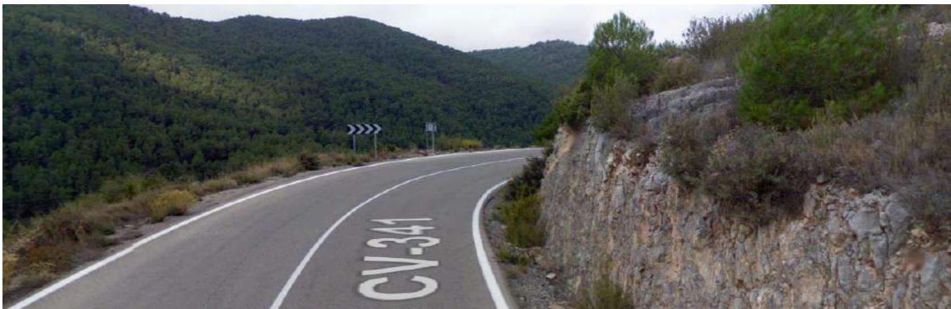
Zona de baja visibilidad (Sentido creciente)
