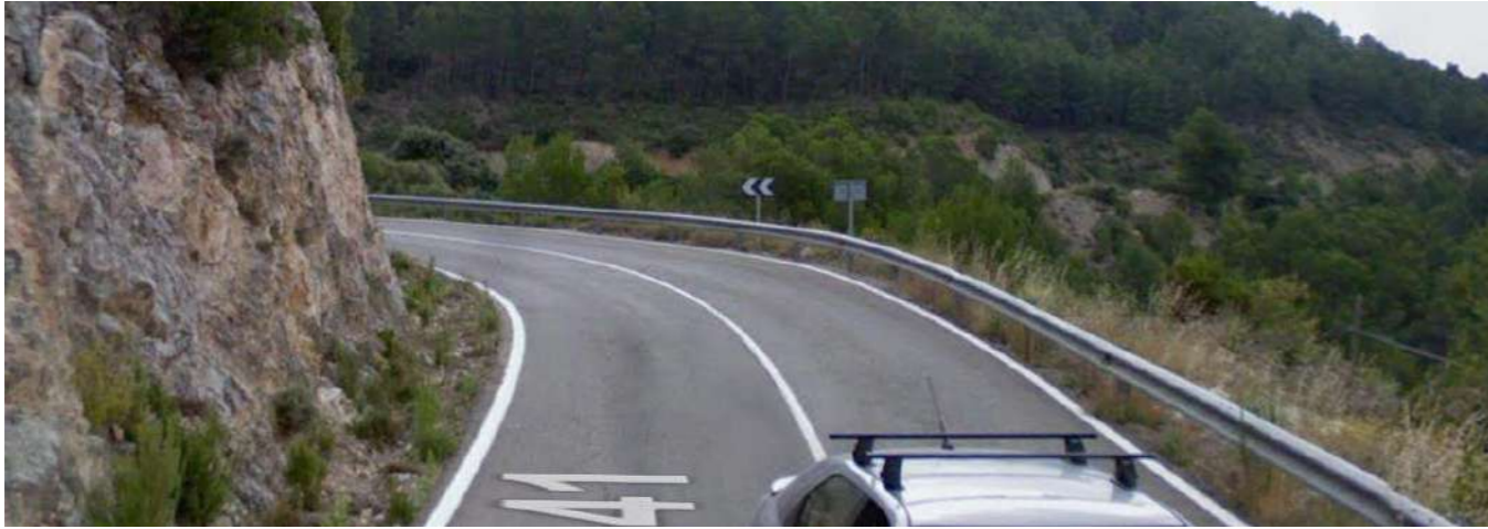
Zona de baja visibilidad (Sentido decreciente)
