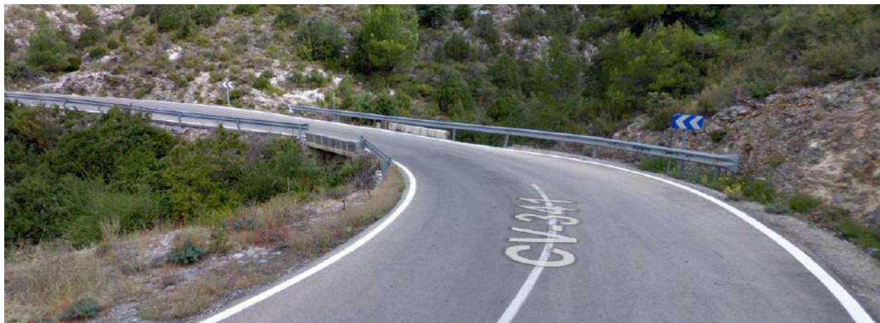
Estrechamiento en obra de paso
