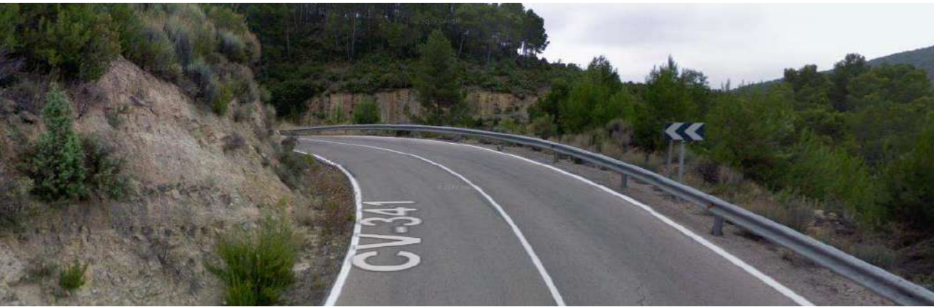
Zona de baja visibilidad (Sentido decreciente)
