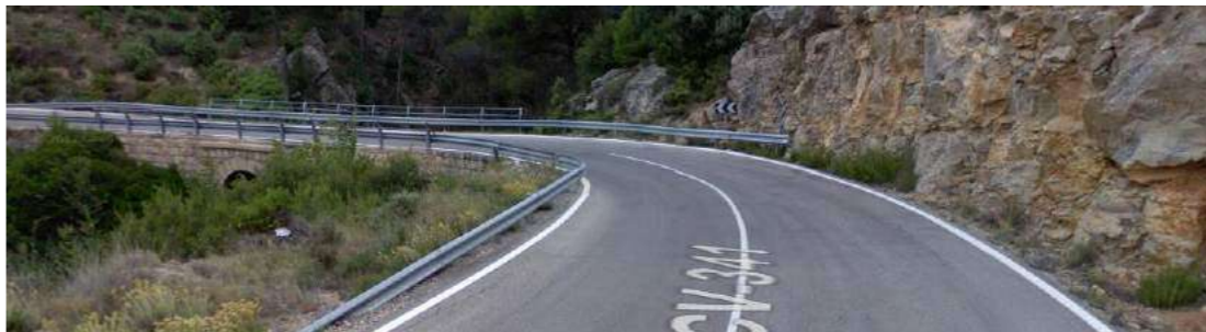
Estrechamiento en obra de paso
