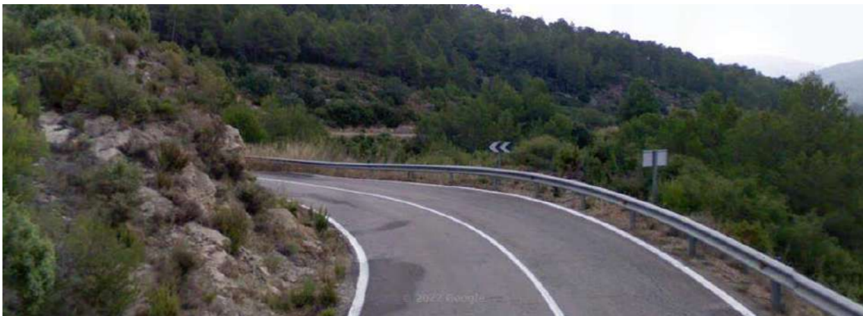
Zona de baja visibilidad (Sentido decreciente)
