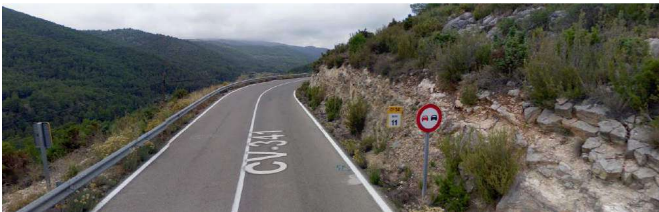
Zona de baja visibilidad con indicación de preferencia entre sentidos (Sentido creciente)
