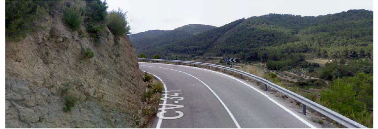
Zona de baja visibilidad (Sentido decreciente)
