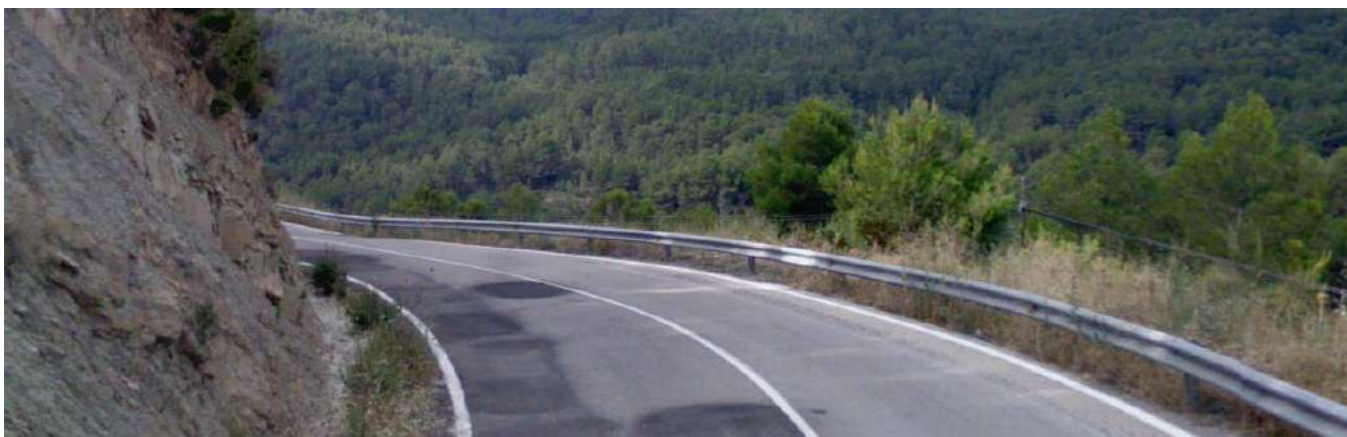
Zona de baja visibilidad (Sentido decreciente)
