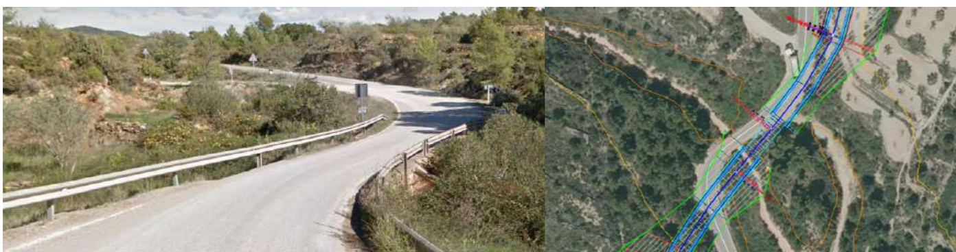
Imagen 3: Modificación de la obra de paso en los P.Ks 1+237,27 a 1+259,04 Fuente: Elaboración propia
