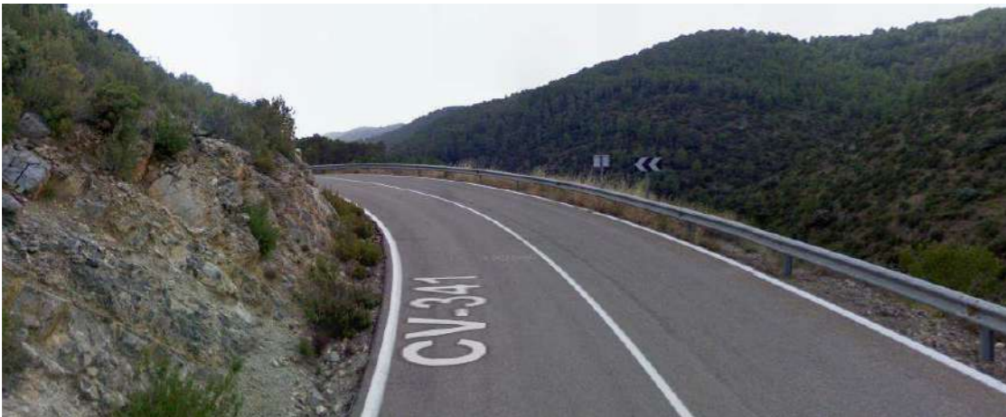
Zona de baja visibilidad (Sentido decreciente)
