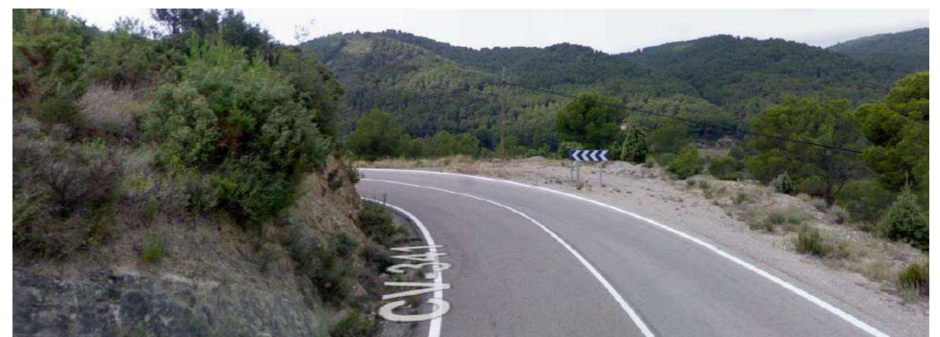
Zona de baja visibilidad (Sentido decreciente)
