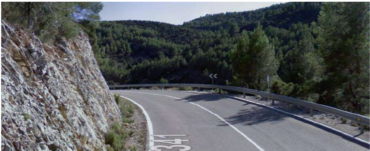
Zona de baja visibilidad (Sentido decreciente)
