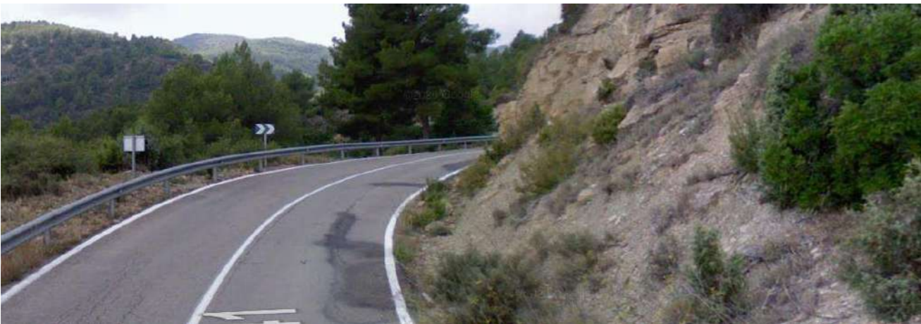
Zona de baja visibilidad (Sentido creciente)
