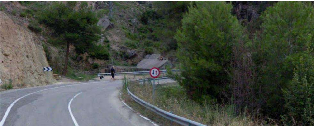
Zona de baja visibilidad en estrechamiento por obra de paso (Sentido decreciente)
