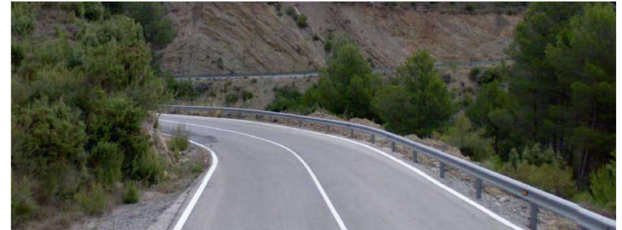
Zona de baja visibilidad (Sentido decreciente)
