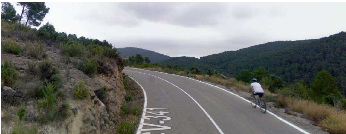
Zona de baja visibilidad (Sentido decreciente)
