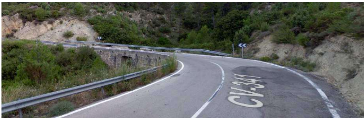
Estrechamiento en obra de paso
