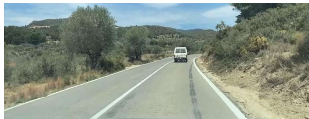
Imagen 9: Ejemplo de taludes de diseño observados en la carretera CV-341 (tramo 1) Fuente: Elaboración propia
