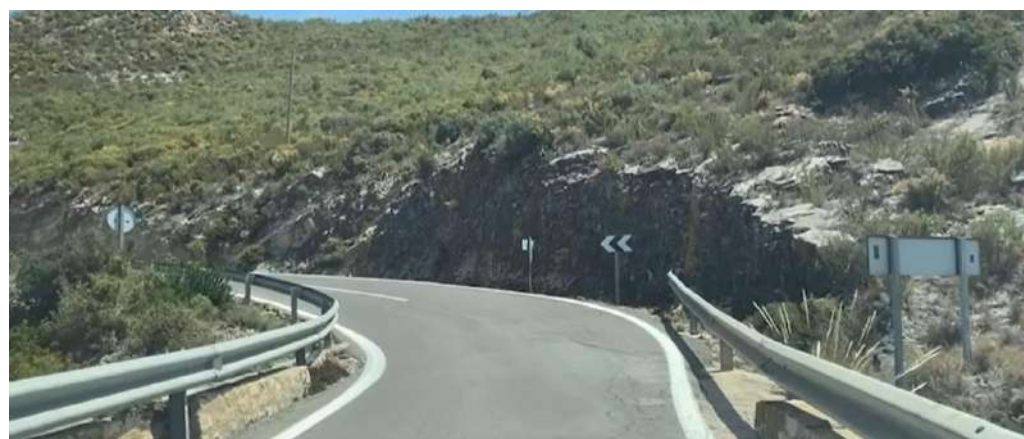
Imagen 8: Ejemplo de taludes de diseño observados en la carretera CV-341 (tramo 1) Fuente: Elaboración propia
