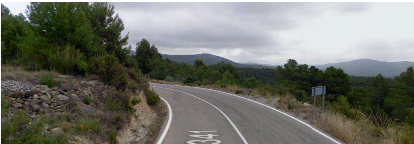
Zona de baja visibilidad (Sentido decreciente)
