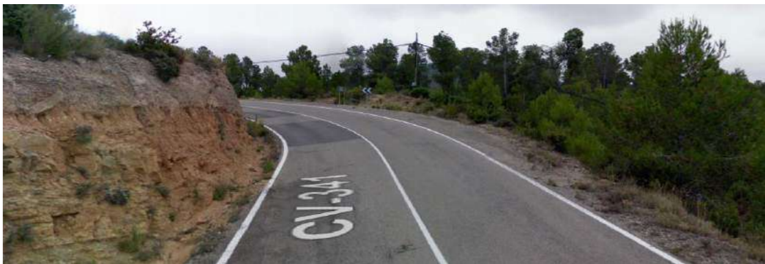
Zona de baja visibilidad (Sentido decreciente)
