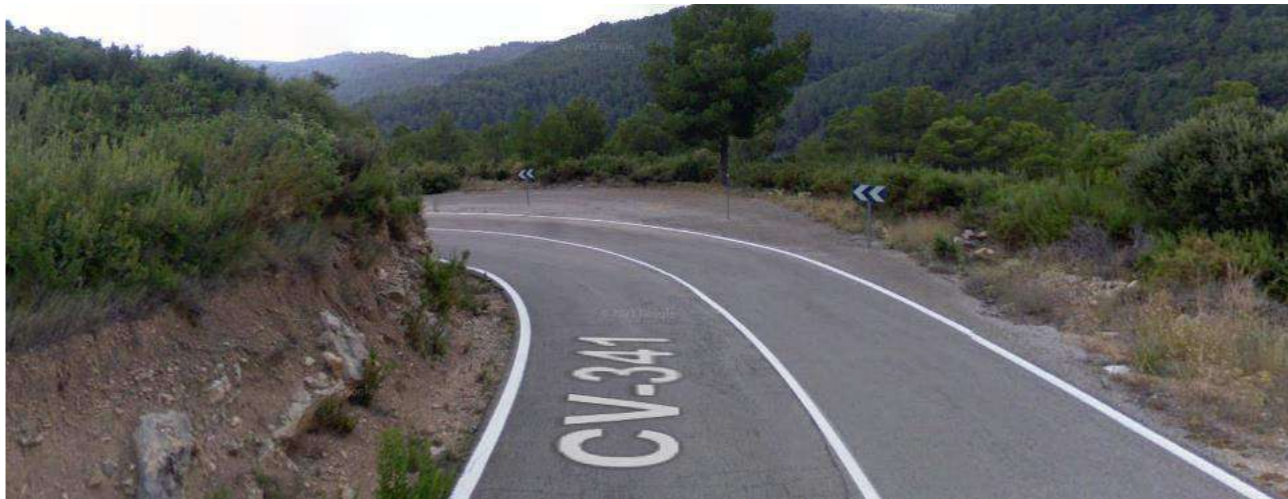
Zona de baja visibilidad (Sentido decreciente)
