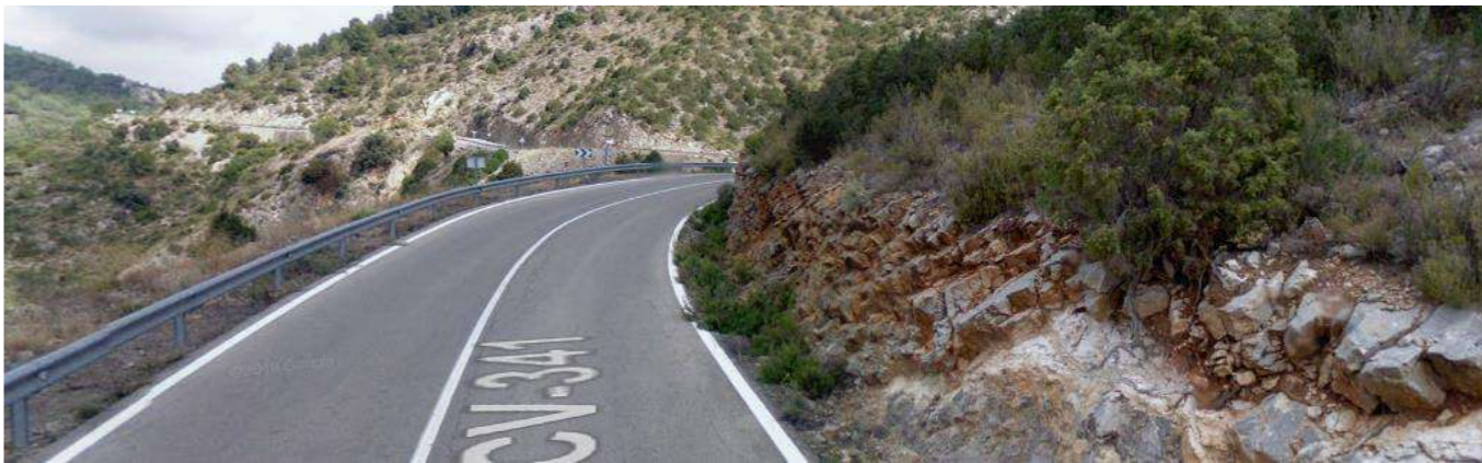
Zona de baja visibilidad (Sentido creciente)
