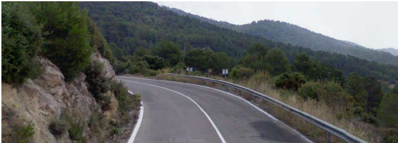
Zona de baja visibilidad (Sentido decreciente)
