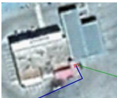
Figura 41. Ubicación de cuadro de protecciones e inversor
