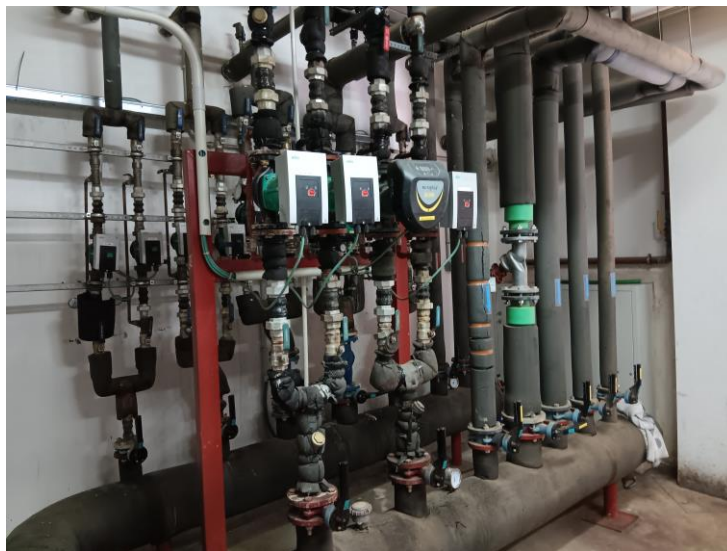
Figura 7. Colector de agua y derivaciones
