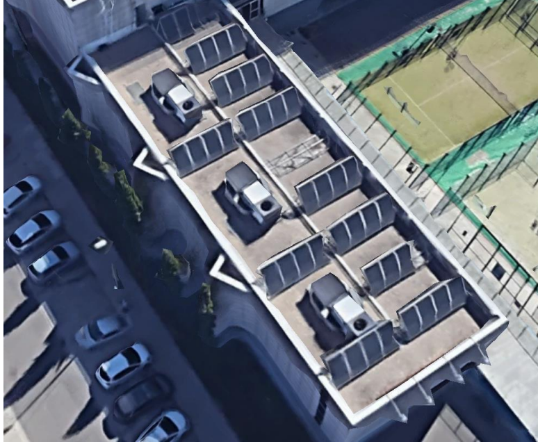
Figura 9. Captadores solares en vista aérea
