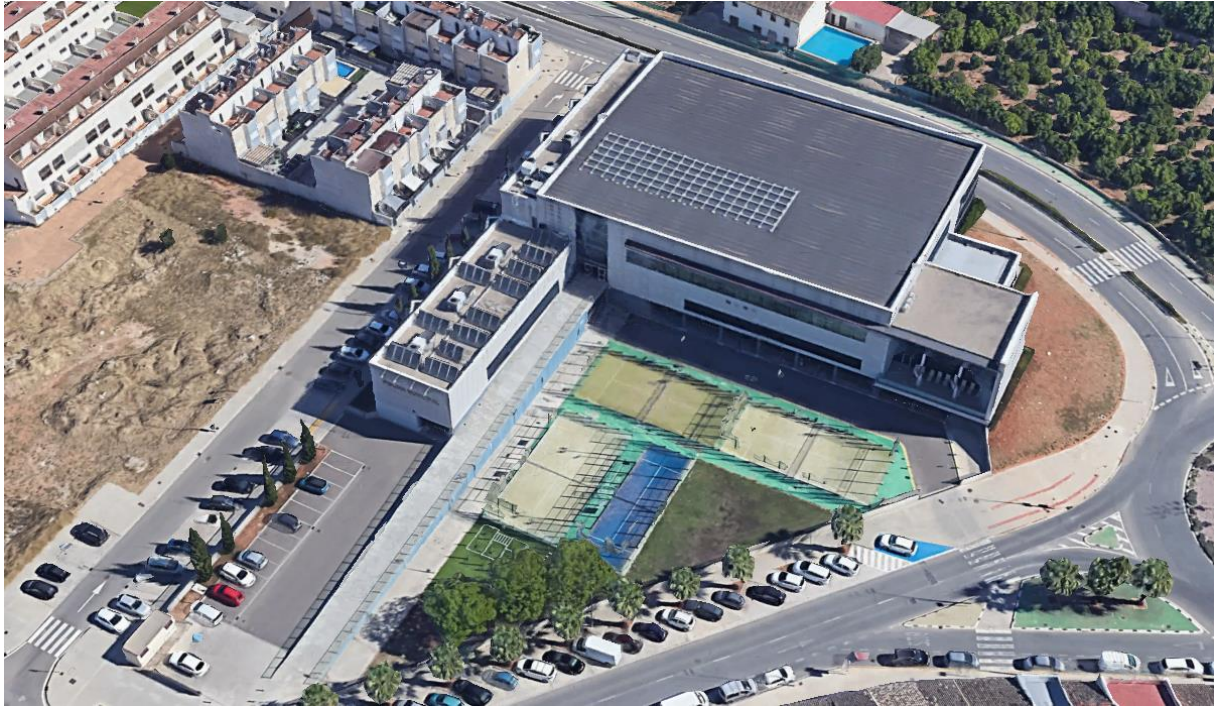
Figura 3. Vista general de la Piscina Cubierta de Carcaixent
