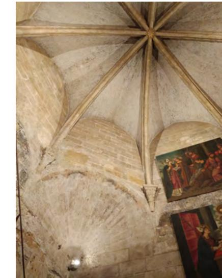
Fig. 57. Trompa cónica de la bóveda (imagen propia)
