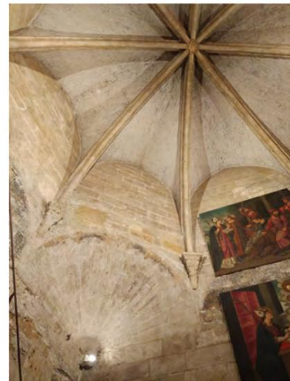
Fig. 57. Trompa cónica de la bóveda (imagen propia)
