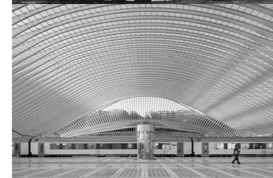
Estación de Liège-Guillemins Santiago Calatrava 2009 Lieja, Bélgica
