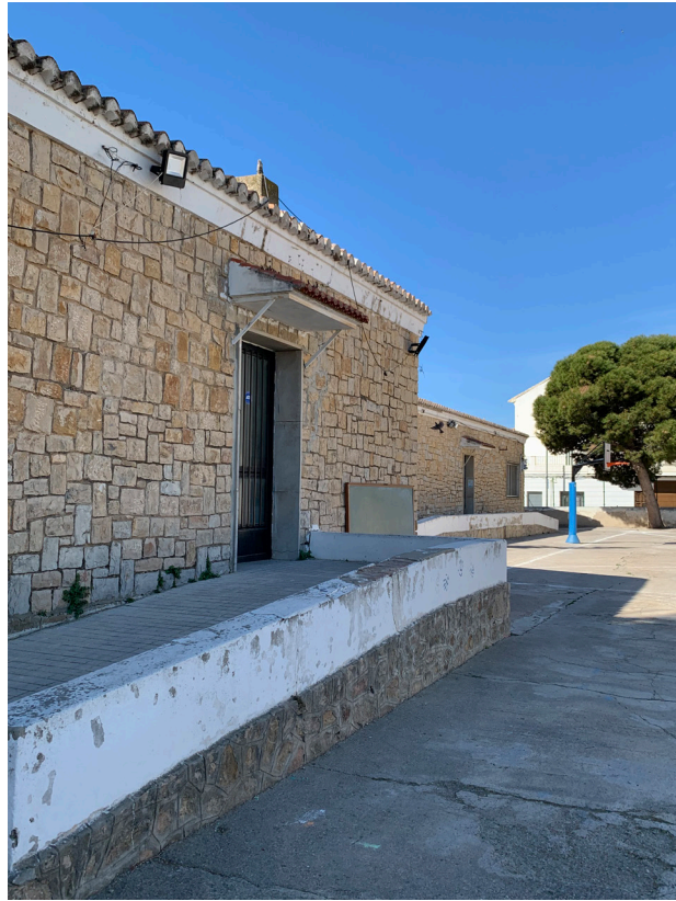
[F/ 3.3.31] Rampa de entrada al aula de infantil. Fuente de elaboración propia.
