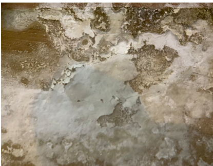
Fig. 59. Detalle de concreciones calcáreas.
