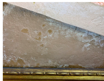
Fig. 50. Velo blanquecino y concreciones calcáreas en zona inferior.
