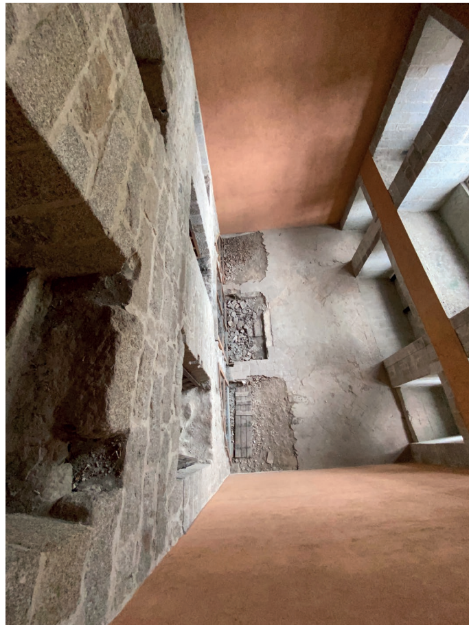
Figura 4. Monasterio de San Lorenzo de El Escorial, fotografía del interior del espacio de la fachada doble de la cocina antigua del Convento, inaccesible, que se ha obtenido con un palo para selfies desde el nivel de los 45 pies. Véase la sección de la Figura 7.
