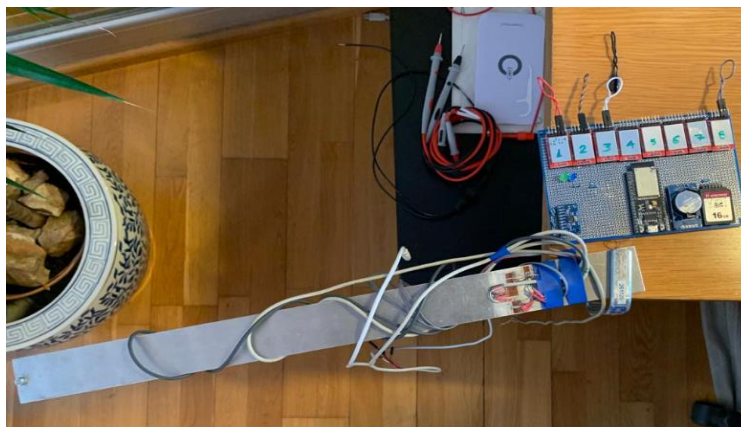
Img. 68: Modelo de galgas extensométricas para la monitorización de los pilares de planta baja.
