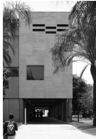
Img. 26: Remodelación ETSA, Valencia, España. Autor: Estudio VVV Año:2012
