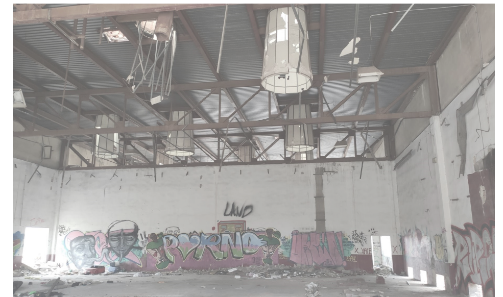
Figura 13. Antigua nave de servicios y posterior emplazamiento de los talleres en el proyecto
