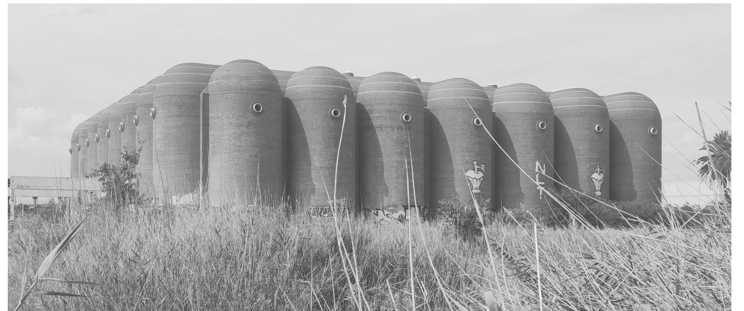
Figura 1. Estado actual de las fachadas de las antiguas Bodegas Vinival, en La Patacona.
