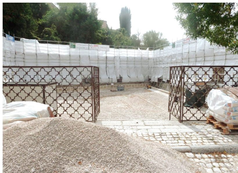
Figura 9: Proceso de restauración de la Fontana (2010).
