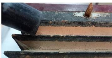
Fig. 41. Limpieza mecánica mediante aspiración controlada.
