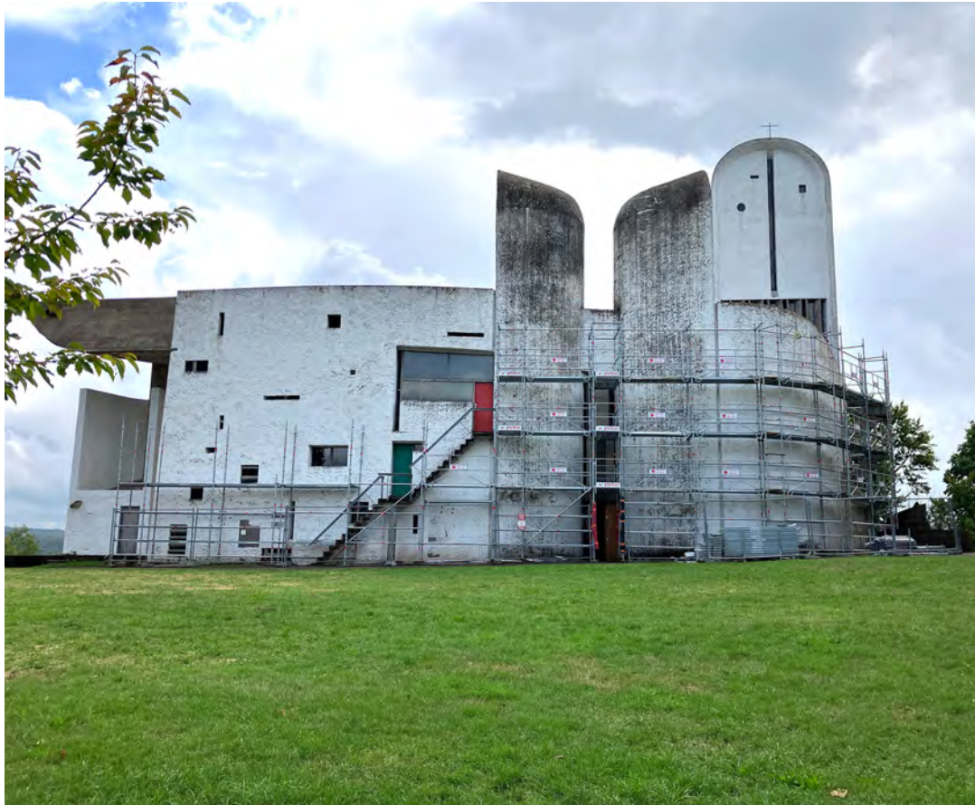
FIG. 4 Imagen del estado del alzado norte durante las obras de rehabilitación (2 de septiembre de 2022). Fuente: autor (2022). ©AONDH/ADAGP
