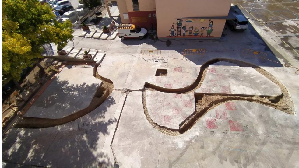
Figura 85. Escavación para la cimentación del murete del nuevo patio de la Escola Sant Ignasi. ('Adequació Del Pati de l'Escola Sant Ignasi' n.d.)
