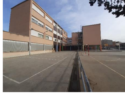
Figura 70. Pista deportiva y área de pavimento duro anexa. ('Adequació Del Pati de l'Escola Sant Ignasi' n.d.)
