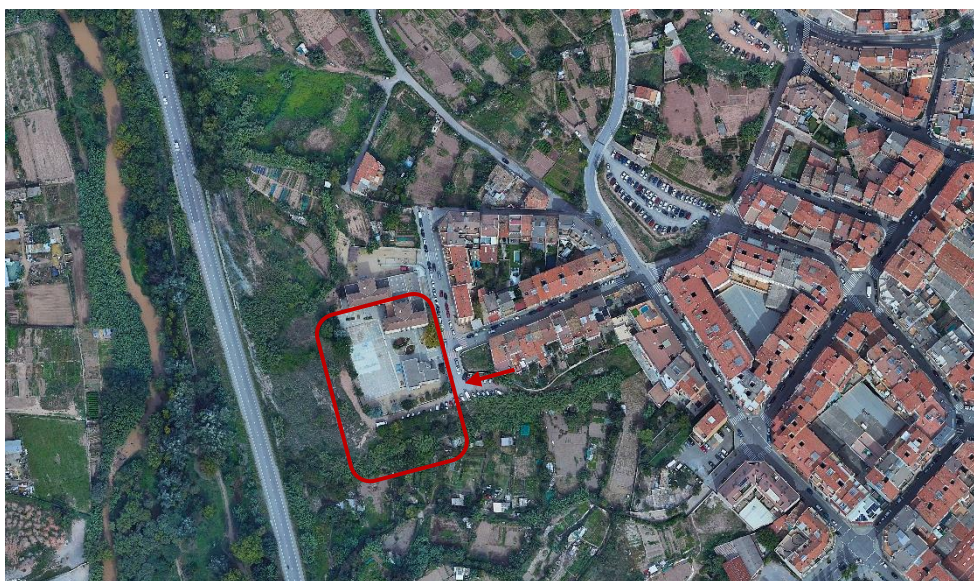
Figura 44. Vista aérea con indicación de la ubicación de la Escuela Sant Ignasi y su ingreso. Elaboración propia.
