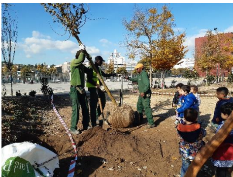
Figura 55. Operarios plantando un árbol de la nueva propuesta frente a los alumnos. ('Adequació Del Pati de l'Escola Salvador Llobet' n.d.)
