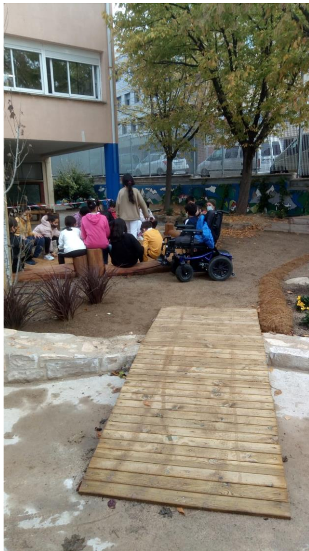
Figura 86. Rampa para salvar los desniveles de la nueva intervención de renaturalización. ('Adequació Del Pati de l'Escola Sant Ignasi' n.d.)
