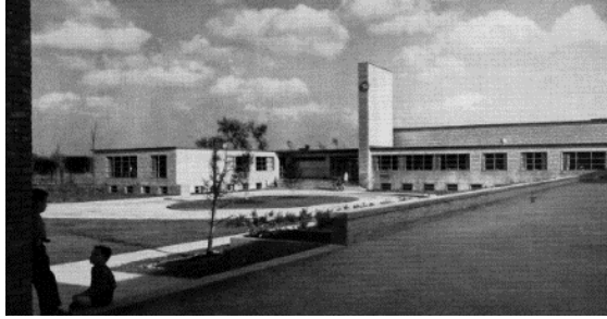
Figura 6. Foto exterior del acceso del Crow Island School (Roth 1950, 113).
