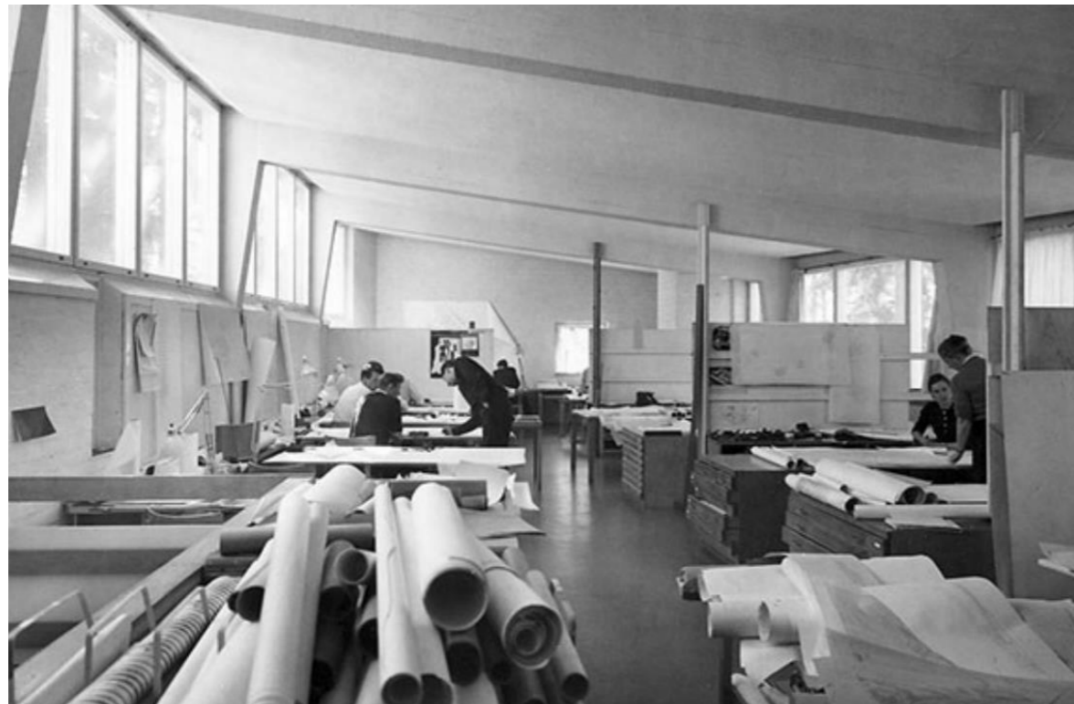
Fig 14. Estudio de arquitectura de Alvar Aalto en los años 50, donde no hay presencia de la tecnología.
