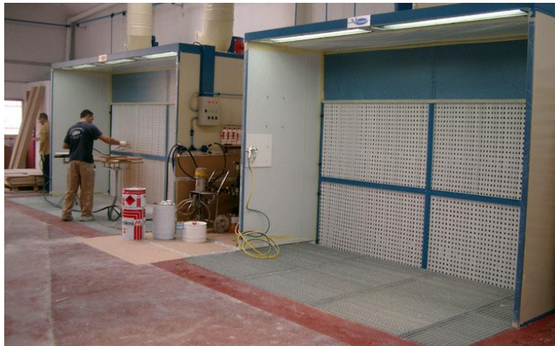
Ilustración 61-instalación de pintura mediante pistola
