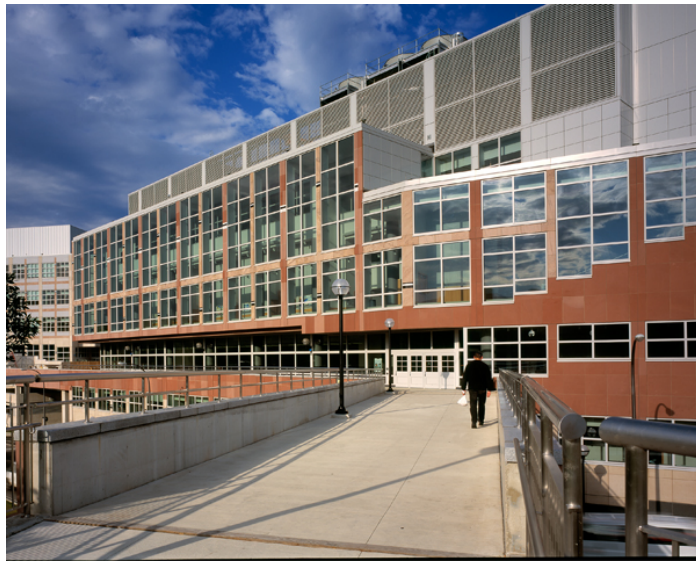
Fig. 16. Circulación peatonal sobre la autovía Palmer Drive, 2004. (Punto B).
