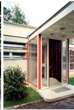
Casa Schminke, marquesina de acceso, en 1933 (foto: A. Kerling, archivo AdK), y en 2000 (foto: Wolfgang Reuss)
