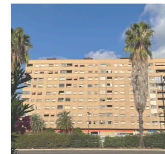
Tipología edificatoria. Avenida de las Cortes Valencianas
