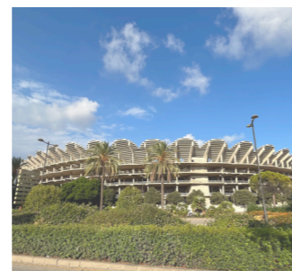
Futuro estadio Nou Mestalla junto a la Avda. Cortes Valencianas
