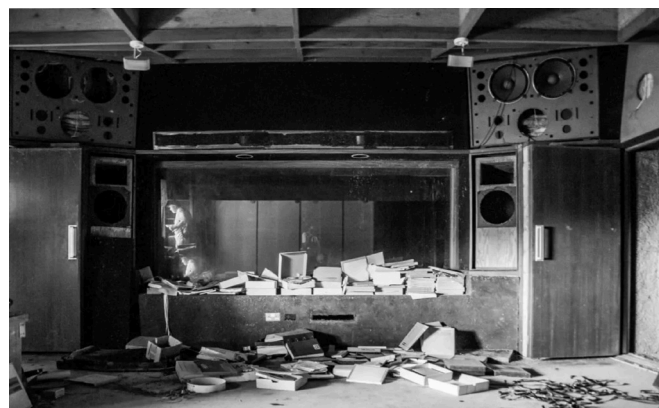
Figura 17. Sala de control de AIR Montserrat tras el huracán.
