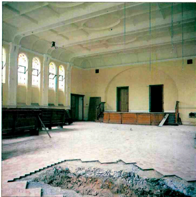
Figura 46. Studio 1 durante las obras de rehabilitación. Studio Sound. Diciembre 1990.
