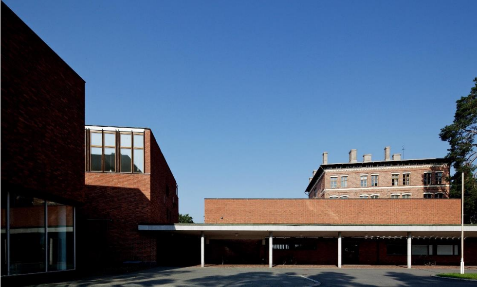
Imagen 48. Fachada principal de la biblioteca.
