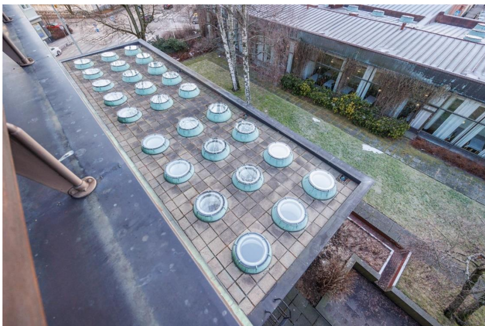
Imagen 60. Lucernarios de la cubierta.
