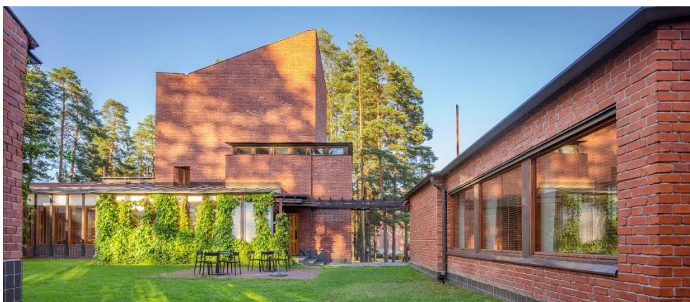
Imagen 37. Vista desde el patio.
